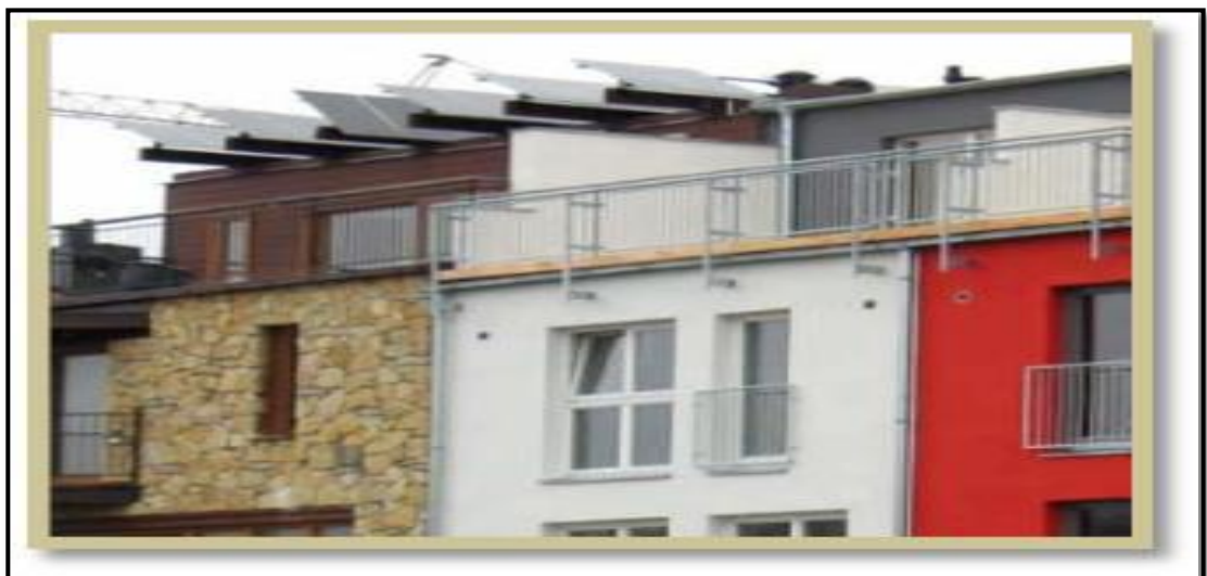
Figure I- 16 : Les capteurs solaires Source : Quartier Durable, guide d'expérience européenne
