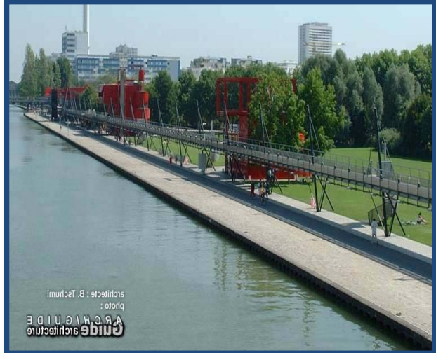
Figure I-56 : canal de l'Ourcq source : wikipédia.org
