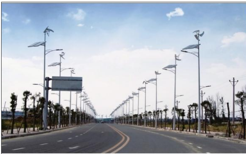
Figure 26 : Des lampadaires à vent et photovoltaïques Source : Google image
