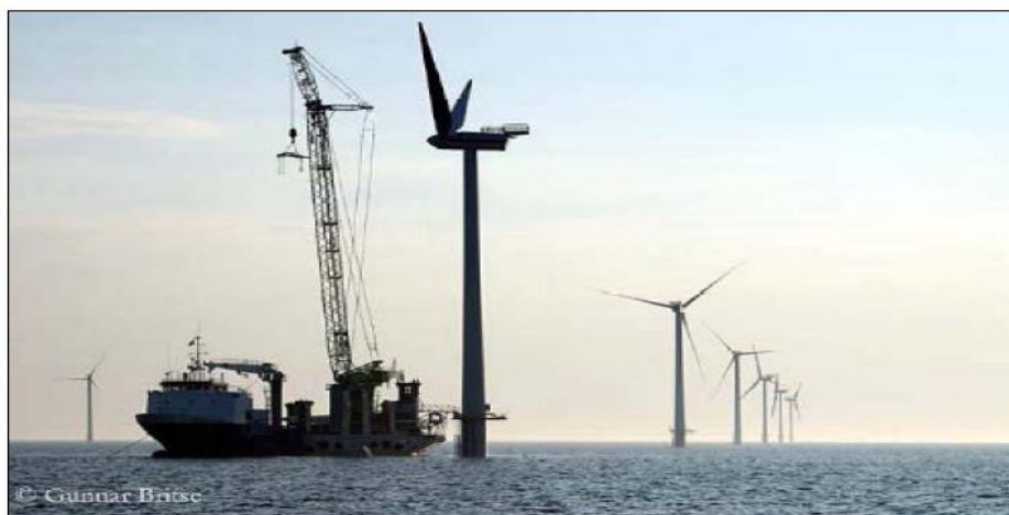
Figure I-8 : Installation d'éoliennes offshore en Mer du Nord (Photo Gunnar Brilse)
