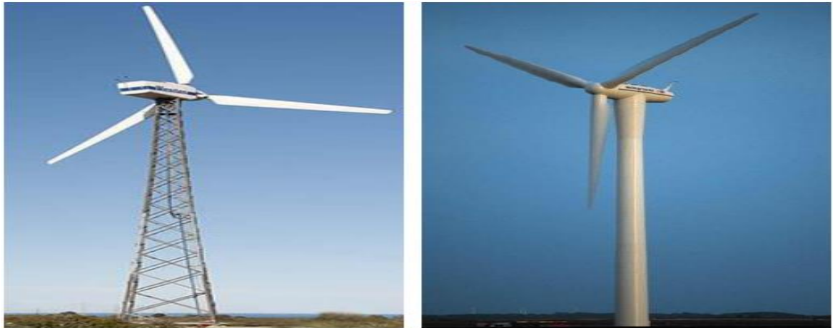
Figure 23: Eoliennes à tour en treillis et à tour tubulaire
