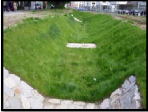
الشكل 1-43: الصورة توضح خندق تصريف المياه.
