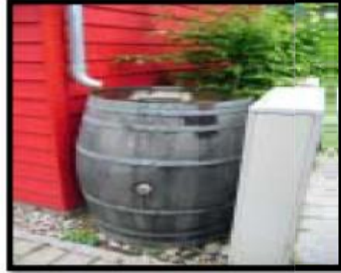
الشكل 1-42: الصورة توضح خزانات مياه الامطار.
