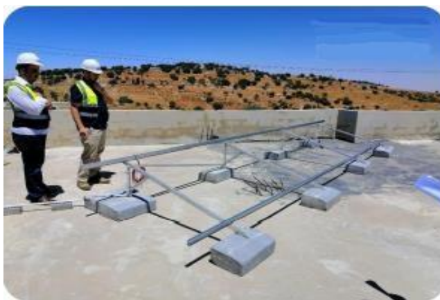
Figure IV. 23 La structure est en aluminium ou en alliage d'aluminium.
