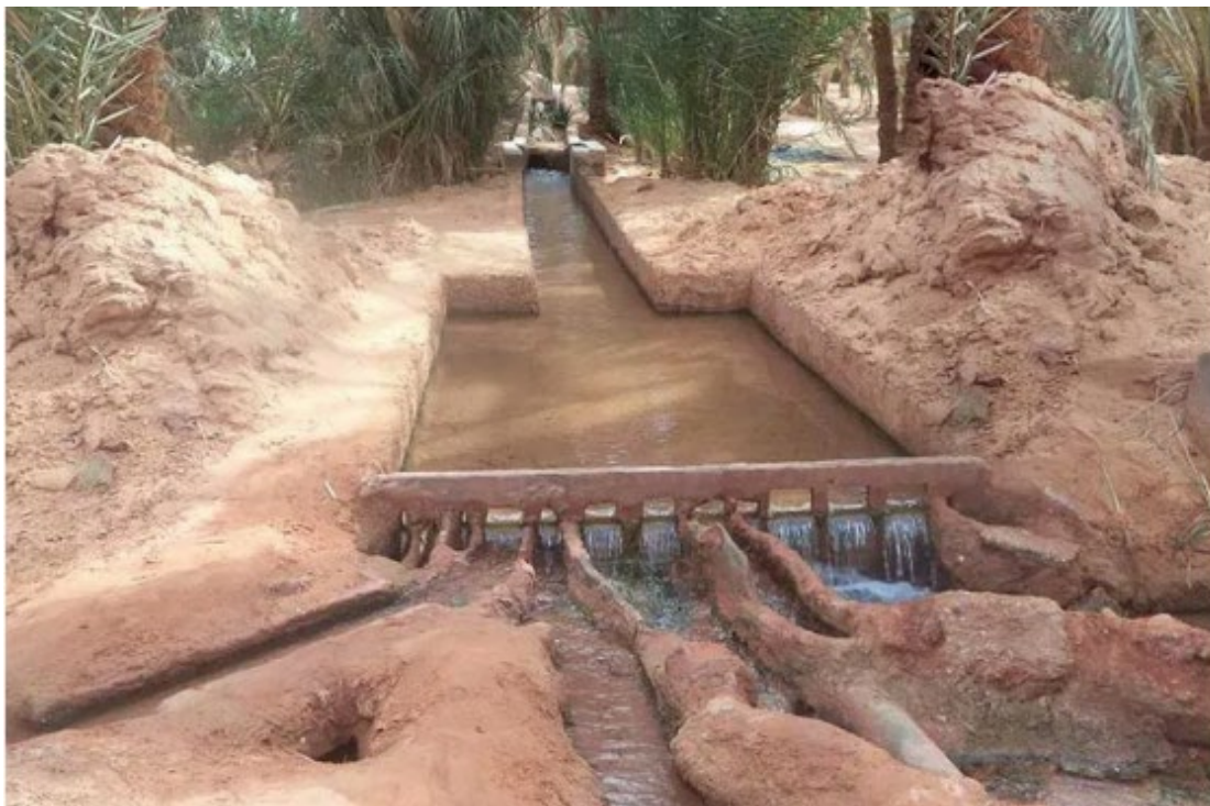
Fig 05: SYSTEM D'IRRIGATION FOGGARA.
