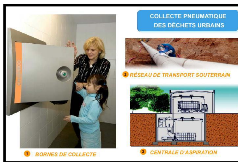
Figure06 : Collecte Pneumatique des déchets Source : www.France, Novembre 2012 p 09
