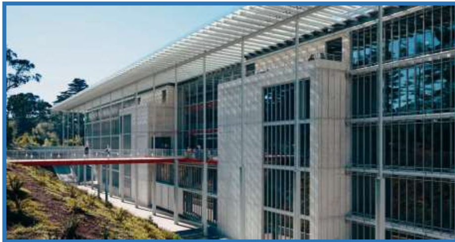
Figure I.11 : la façade postérieure d'Académie des sciences de Californie Source : http://www.architectfuture.com
