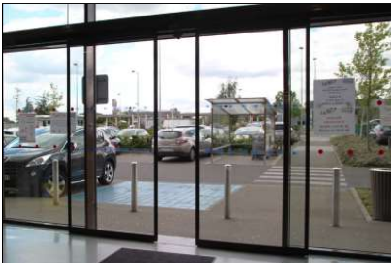
Figure IV.16 : porte d'entrée principale coulissante à ouverture automatique Source : auteur
