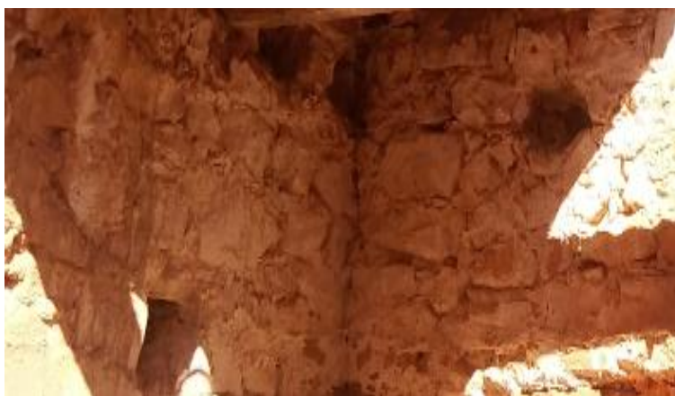
Fig. III.A.51 peinture d'un mur en pierre Source auteur
