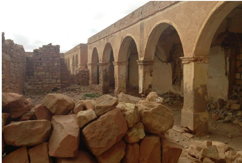
Fig. III.A.20.les galeries de Caravansérail de Sidi Makhloof
