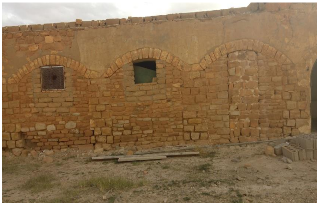
Fig. III.A.24.pierre hourdées au mortier
