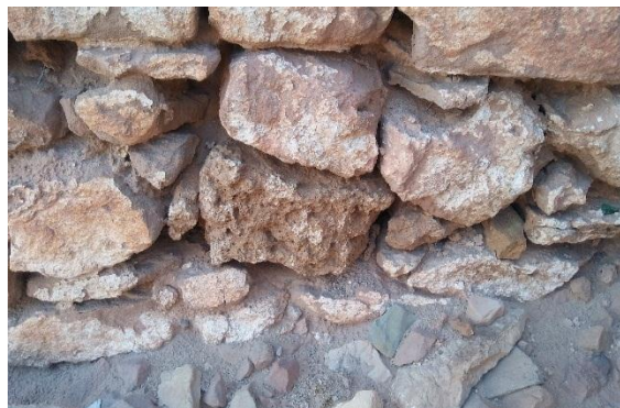
Fig. III.A.56 salpêtre dan un mur d'extérieure Source auteur
