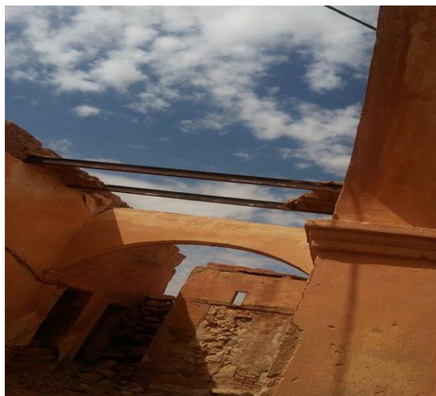
Fig. III.A.64 un ensemble des voutains démolir Source auteur
