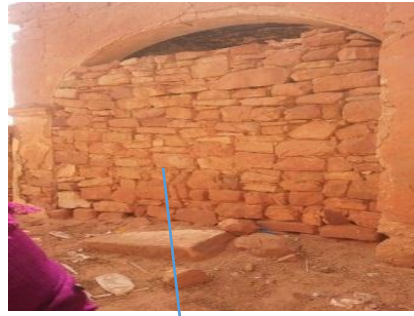
Fig. III.38 partie de déblai
