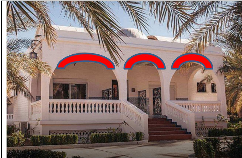
الصورة 16: صورة لواجهة أحد غرف البنغالو
