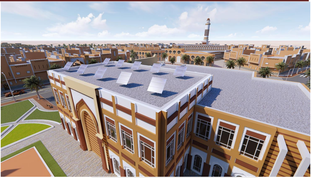
الصورة 14 : توضح توضع الألواح الشمسية على المباني / المصدر: اعداد الطلبة
