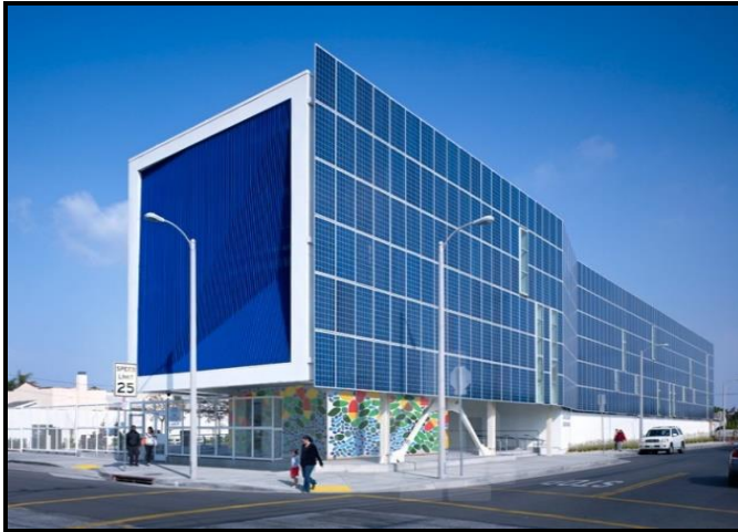
الصورة 03 - 04 : توضح تموضع الألواح الشمسية في المباني
