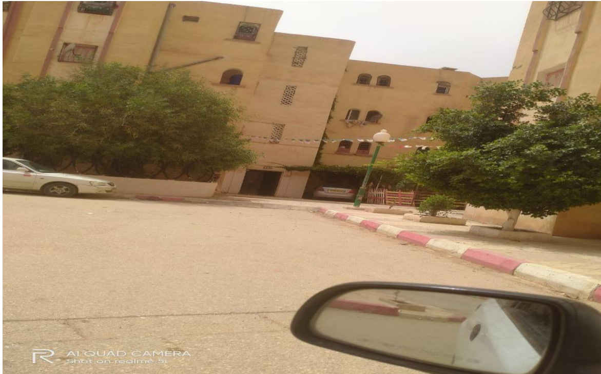
الصورة رقم 05 : توضح بناء مرآب في حي 800 سكن
