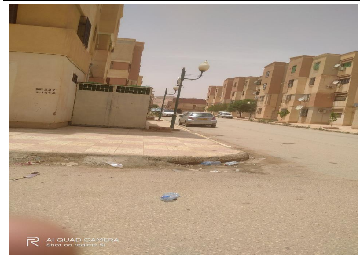
الصورة رقم 22 : توضح بناء مرآب للسيارات بجوار العمارات بحي المحافير
