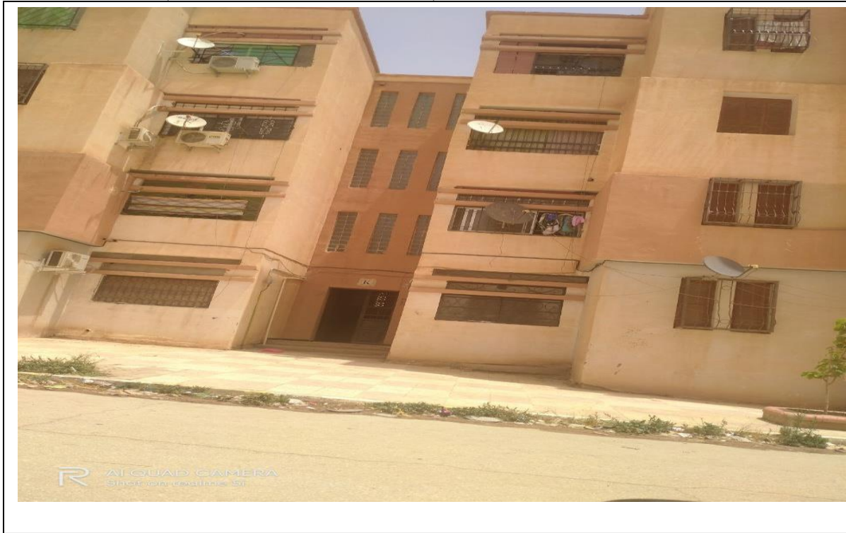
الصورة رقم 24 : توضح اجراء تعديلات على النوافذ بحي المحافير
