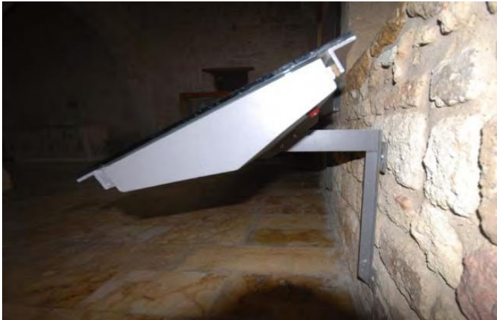
صورة 24 : طريقة تثبيت اللوحات وبشكل مائل.
