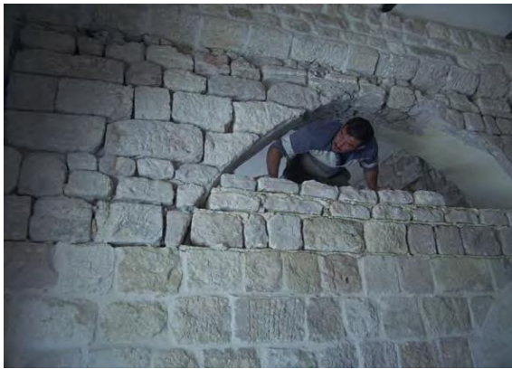
صورة 19 : أعمال الإضافات للجدران الداخلية.
