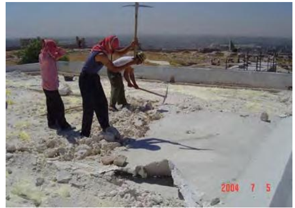
صورة 18 : أعمال الأسقف .
