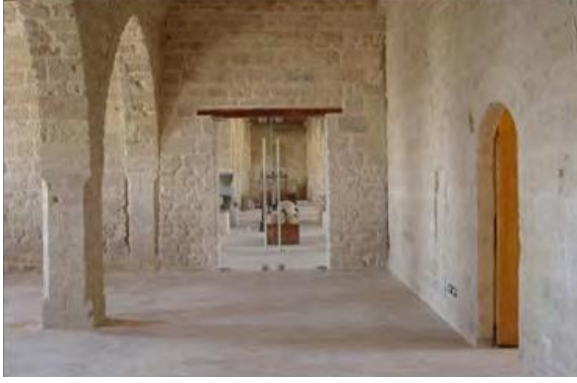
صورة 23 : الأعمدة الداخلية للشكنة بعد الترميم.
