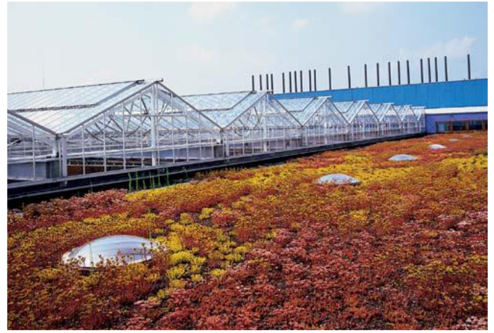
Fig. 10 : toiture végétalisée Source : BEHNISCH ARCHITEKTEN 2014
