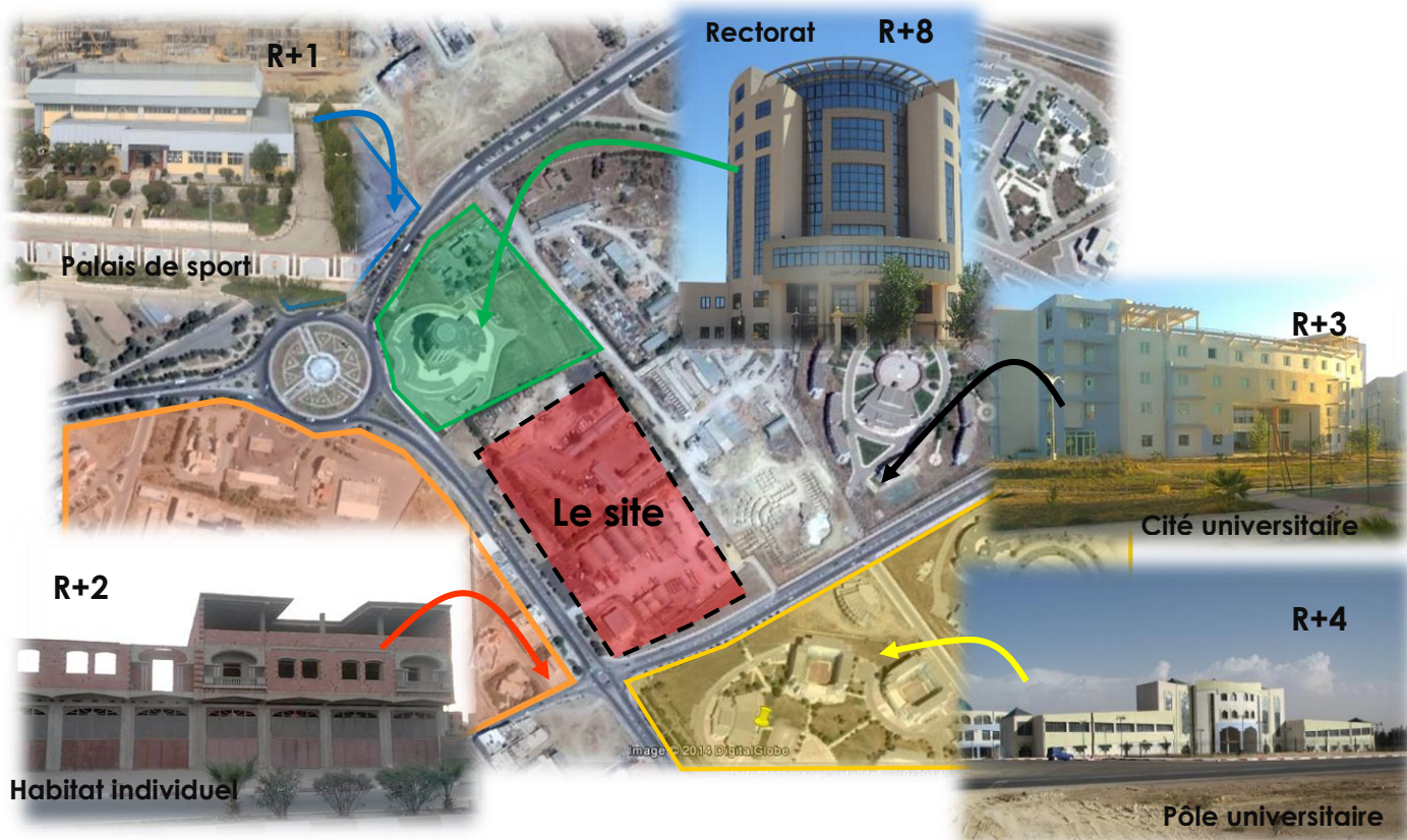
Fig. 38: Localisation de la zone d'étude par vue aérienne Source : Google Earth
