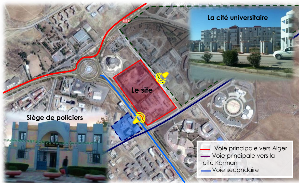
Fig. 43: Les sources de bruit par vue aérienne Source : Google Earth
