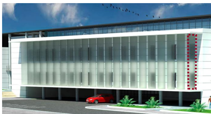
Fig.93: façade sud-ouest avec des brises soleil verticaux Source: Auteur
