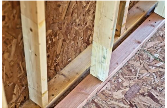
Fig. 30 : Utilisation du bois
