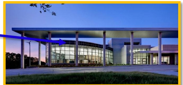
Figure 1-7 les façades de l'équipement. www.ArchDaily.com
