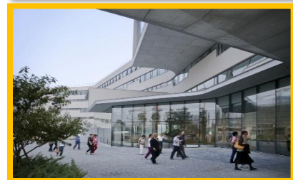
Figure 1-24 les façades de l'équipement. www.ArchDaily.com
