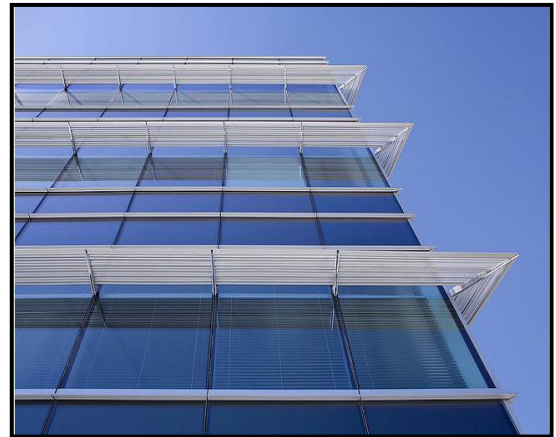
Figure 2-10 éléments de contrôle amovibles. Source : www.energie.arch.ucl.ac.be
