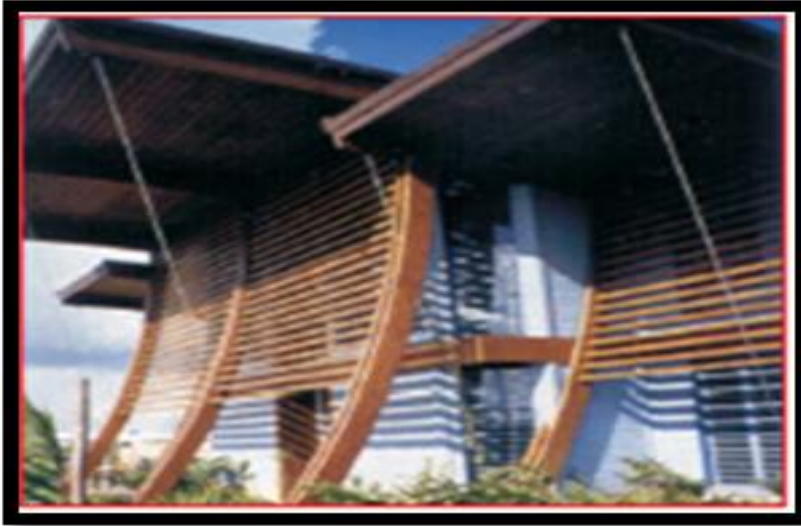
Fig III-11 : immeuble de bureaux et ateliers bai mahault (Guadeloupe arch .p.huguel)
