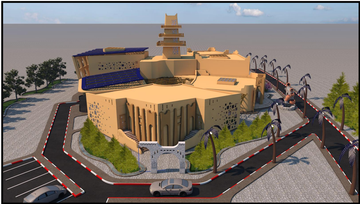
Fig IV. 28 : façade est Source : Auteurs
