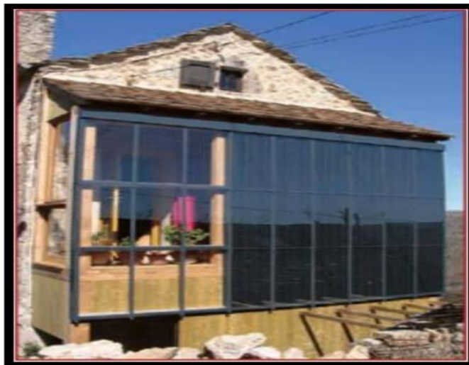
Fig I-20 : mur trombe.[Source :l'énergie solaire thermique et photovoltaïque ].
