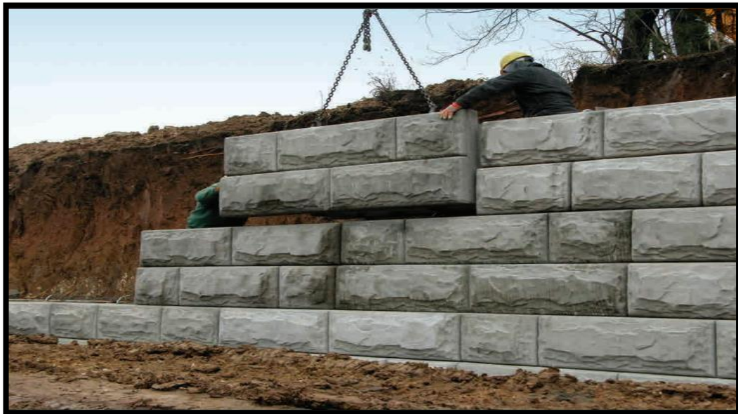
Fig I.6 : Mur poids constitué de poutres préfabriquées.
