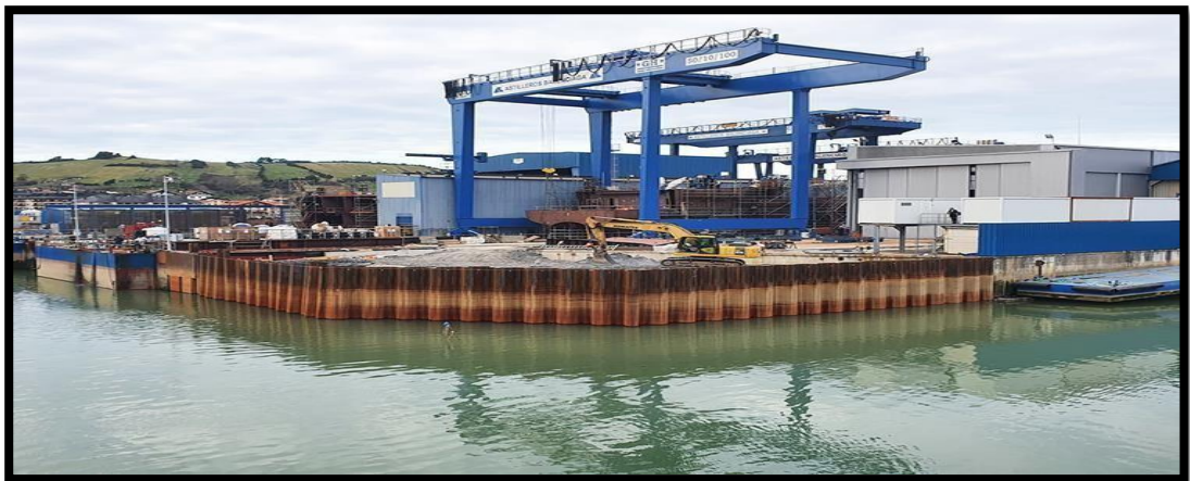
Fig I.2 : Les rideaux de palplanches métalliques
