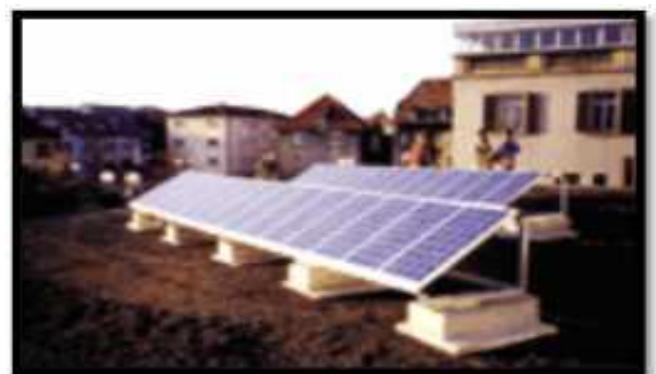
Figure 12 : les panneaux solaires.
