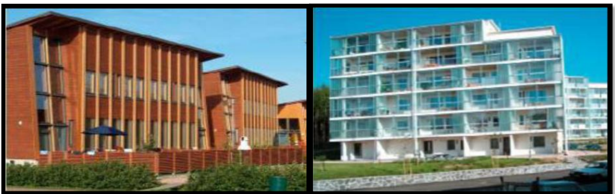
Figure 25 : les grandes surfaces de vitrage dans les bâtiments,
