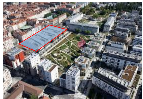
Figure 45 : les panneaux photovoltaïques sur le côté commerciale Source : PDF de bonne de Grenoble
