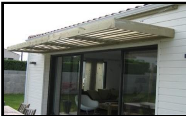
Figure 29 : brises solaires intégrer dans un habitat
