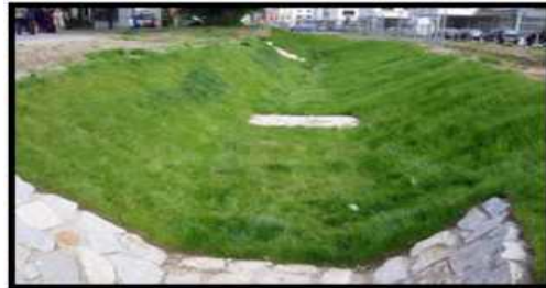
photo 7 : un caniveau pavée pluviales
