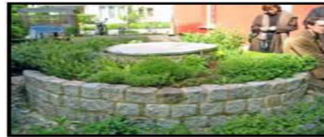
Photo 8 : d'un bassin d'orage végétalisé
