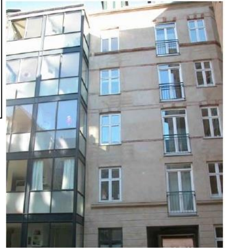
Photo10 : des façades avant et après la réhabilitation
