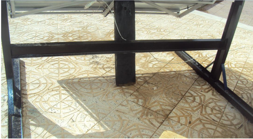
Fig V.23 : Photo de la structure porteuse
