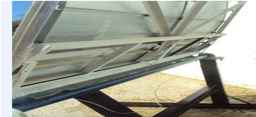
Fig V.24 : photo du tube rond qui assure l'inclinaison
