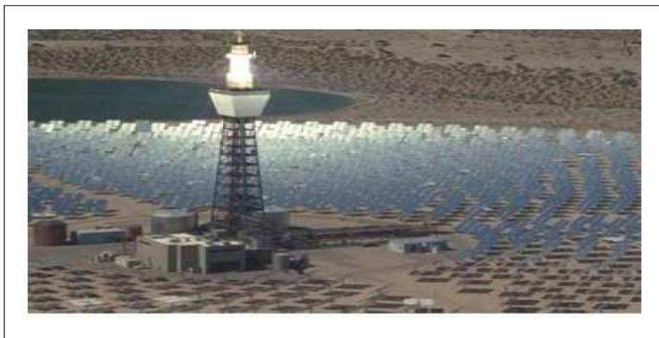
Fig.III.7 : Concentrateur centrale a tour [8]
