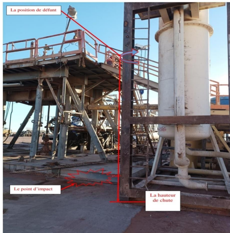
Figure 9. Localisation de l'accident de chute.
