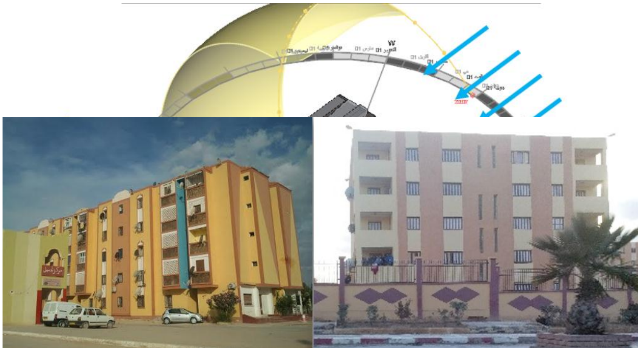
Figure 5:14 Photos des façades en proximité du site Source : Auteurs
