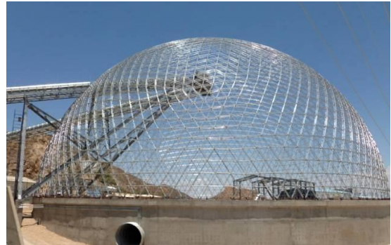
Figure 6:40 exemple du coupole en cours de réalisation
