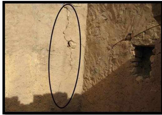
الشكل رقم 105 : الصور (أ،ب) تشققات عميقة واخرى سطحية على مستوى كل اجزاء المباني في القصر
