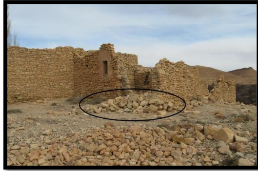
الشكل رقم 104: انهيارات على مستوى الواجهات في القصر
