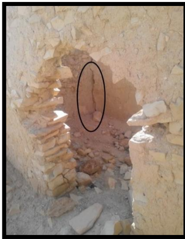
الشكل رقم 105 : الصور (أ،ب) تشققات عميقة واخرى سطحية على مستوى كل اجزاء المباني في القصر
