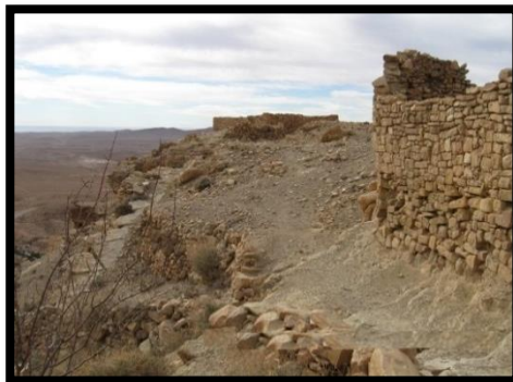
الشكل رقم 102 : انهيارات على مستوى السور في القصر المصدر : من انجاز الطالبة
