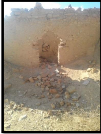
الشكل رقم 103: تلف العناصر المعمارية خاصة الاقواس في القصر المصدر : من انجاز الطالبة
