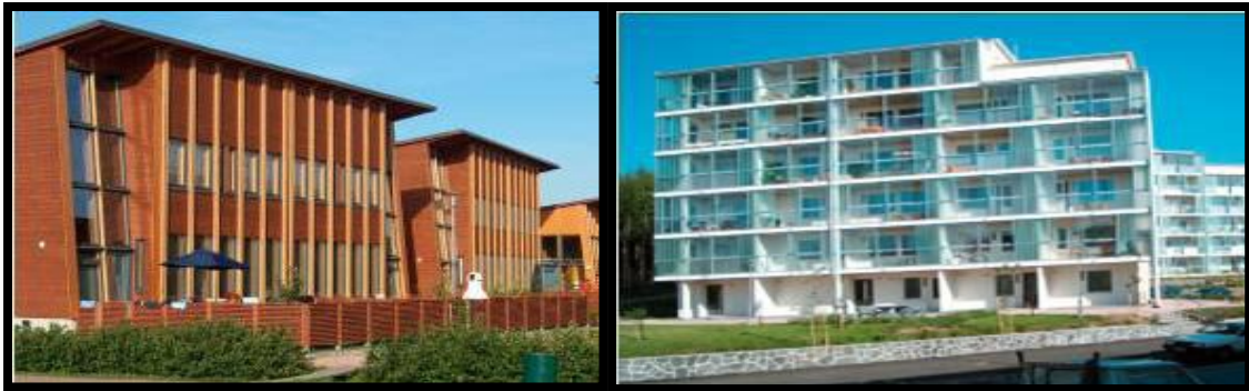
Figure 19 : les grandes surfaces de vitrage dans les bâtiments, Source : www.helsinginenergia.fi/kaukolampo/ekoviikki.html
