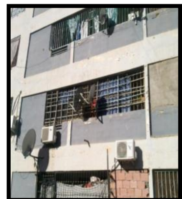
2photo 3/4/5/6 facade changées
