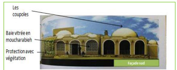
Figure II- II- 23 : Façade sud. Source : revue vies de ville N°22
