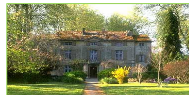
Photo II- 2: Maison isolée. Source : http://www.ageden.org
