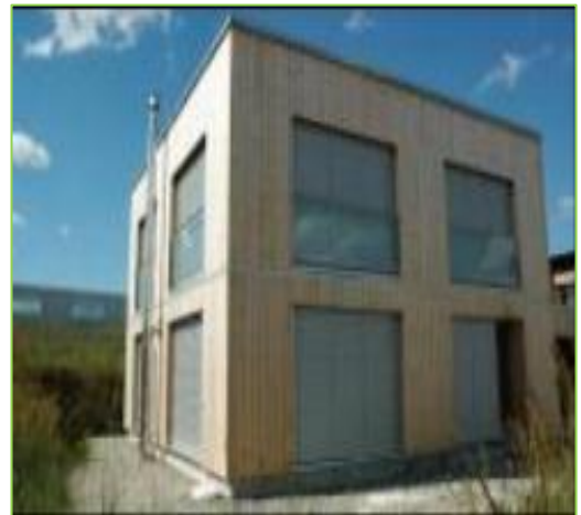
Photo III- 6: Vue Sur La Maison. Source : http://lab-immo.ch/1037-/ Minergie-P-ECO MAISON
