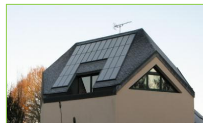
Photo III- 2 : Les capteurs solaires Source: Google image
