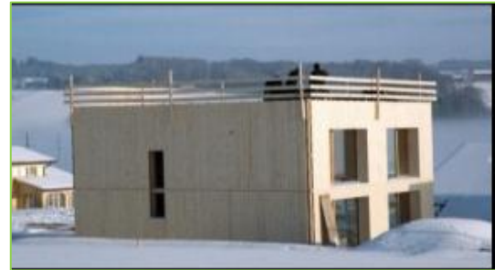
Photo III- 10 :Vue sur la maison, Source : http:// lab-immo.ch/1037/ Minergie-P-ECO MAISON
