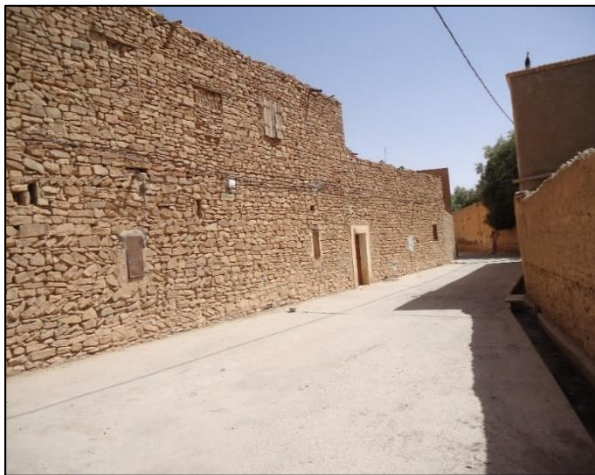
Figure III.15: façade aveugle source : auteurs
