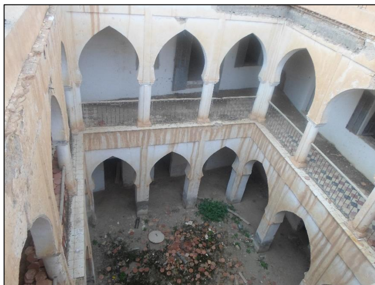
Figure III.29 : le patio de la zaouïa source : auteurs
