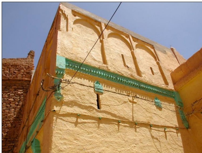
Figure III.23: façade du mausolée source : auteurs
