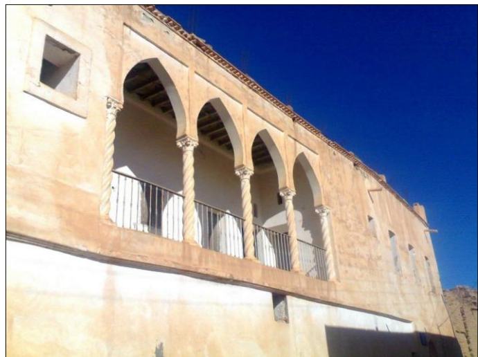
Figure III.21: façade de zaouïa source : auteurs
