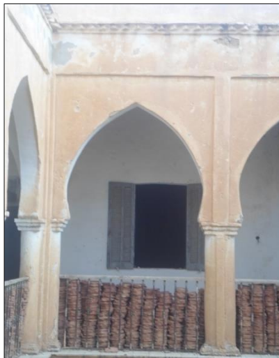
Figure III.20: les arcades de zaouïa source : auteurs
