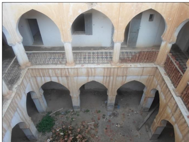
Figure III.22: vue d'intérieur de la zaouïa source : auteurs
