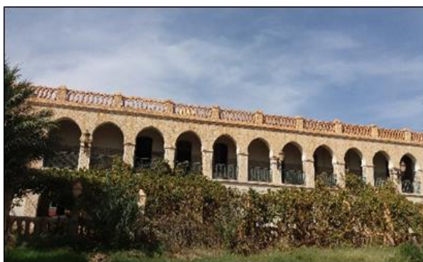
Figure III.32 : la bâtisse "palais Kourdane" source : auteurs
