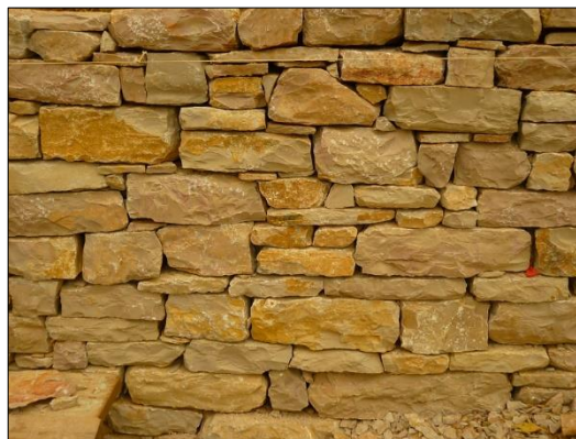
Figure II.7 : mur en pierre sèche source : https://pierressauvages.book.fr
