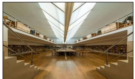
Figure 57: La verrière de la bibliothèque de la faculté d'architecture de l'université de Porto
