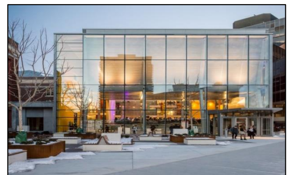
Figure 28: École supérieur d'architecture et de paysage de Bordeaux Source : https://www.archdaily.com
