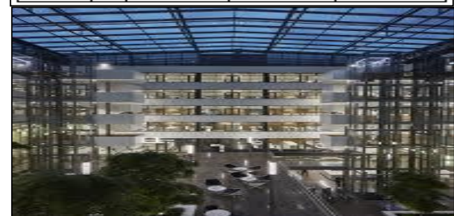
Figure 7: Toiture en Aluminium Source : Le-grand-palais-paris-la-grande-verriere
