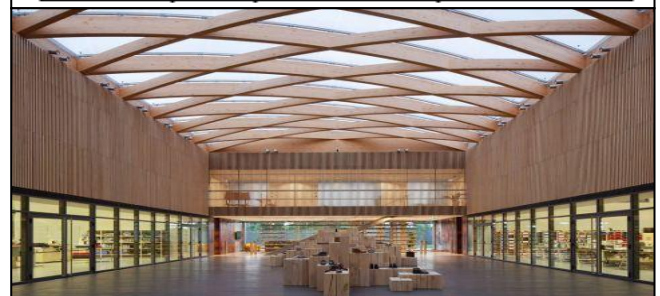
Figure 6: Toiture en bois lamellé-collé Source : https://www.pinterest.com/
