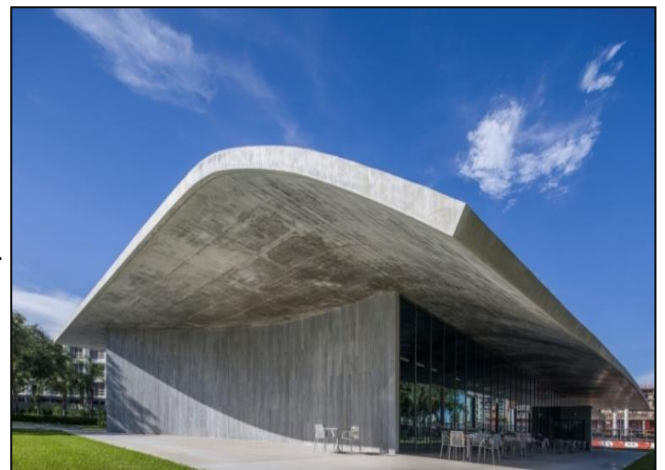
Figure 12: La toiture courbée Source : https://www.archdaily.com
