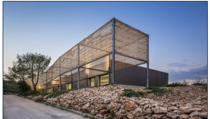
Figure 18: L'extension de l'École d'architecture de Marseille Source : https://www.archdaily.com
