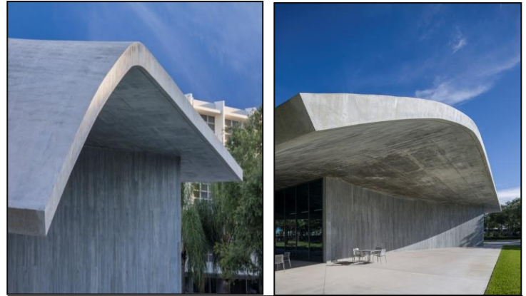
Figure 11: Toiture courbée Source : https://www.archdaily.com
