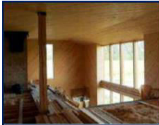
Image 12 : Les toitures de bois. [9]
