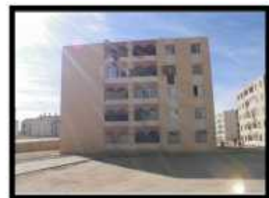
Photo n10 : HABITAT COLLECTIF
