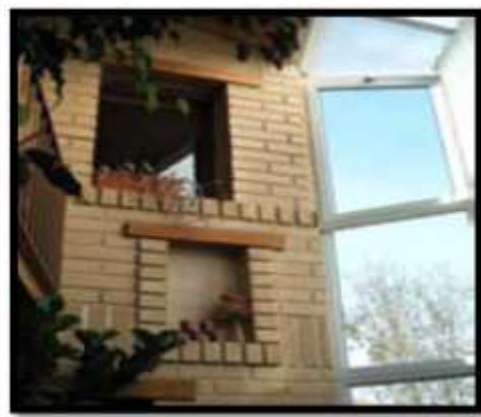
Figure 08 : l'utilisation de la terre crue dans la construction de maison.
