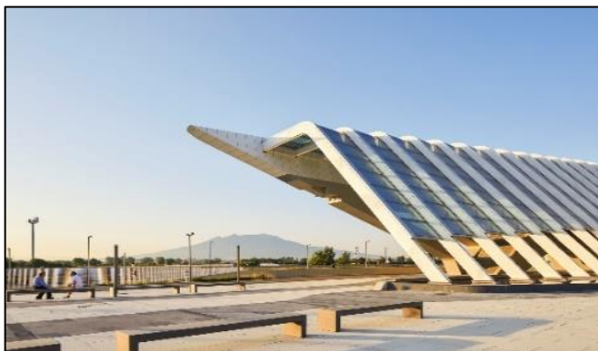
Figure 24 : toiture de la gare Napoli Afragola Source : www.archdaily.com
