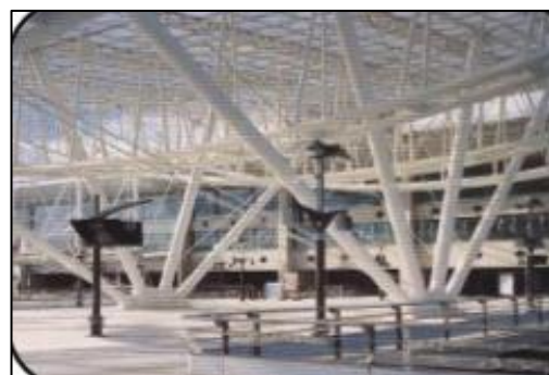
Figure 19 : La structure de Roissy La toiture de gare Satolas
