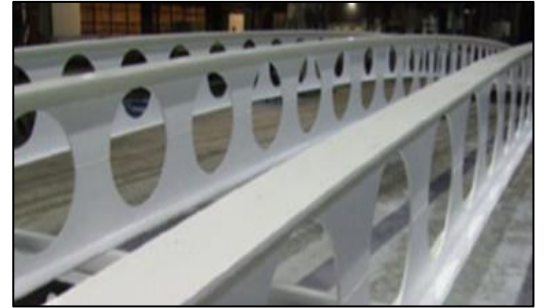
Figure 185: des poutres métalliques alvéolaires
