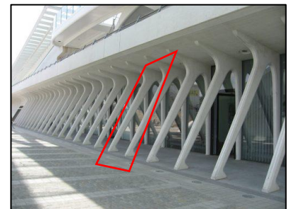
Figure 64: la structure de la gare de liège source : www.wikiarquitectura.com
