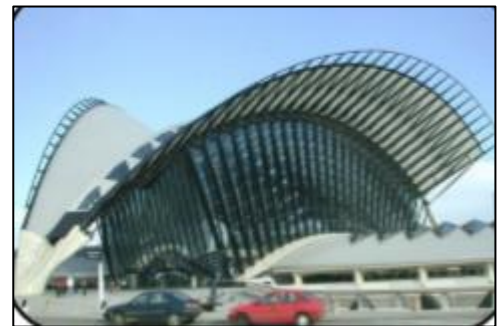
Figure 18 : La toiture de gare Satolas source : http://beuret.net/typologie-des-gares/
