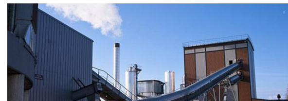
Fig. .5. usine pour l'énergie de la biomasse.
