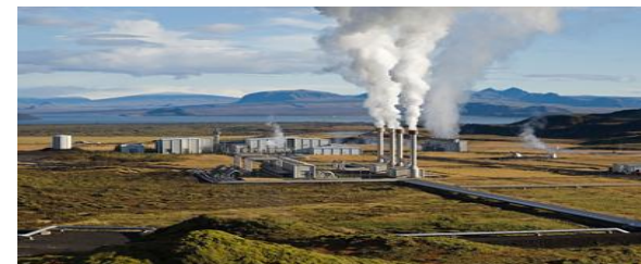
Fig.6. centre de l'énergie géothermique
