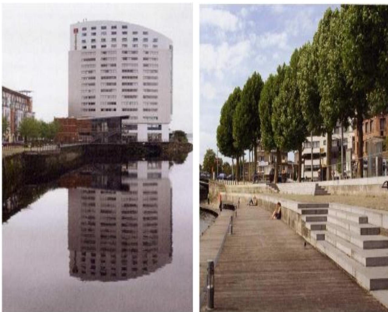
Bassin de rétention des eaux pluriel [www. Strasbourg.fr]
