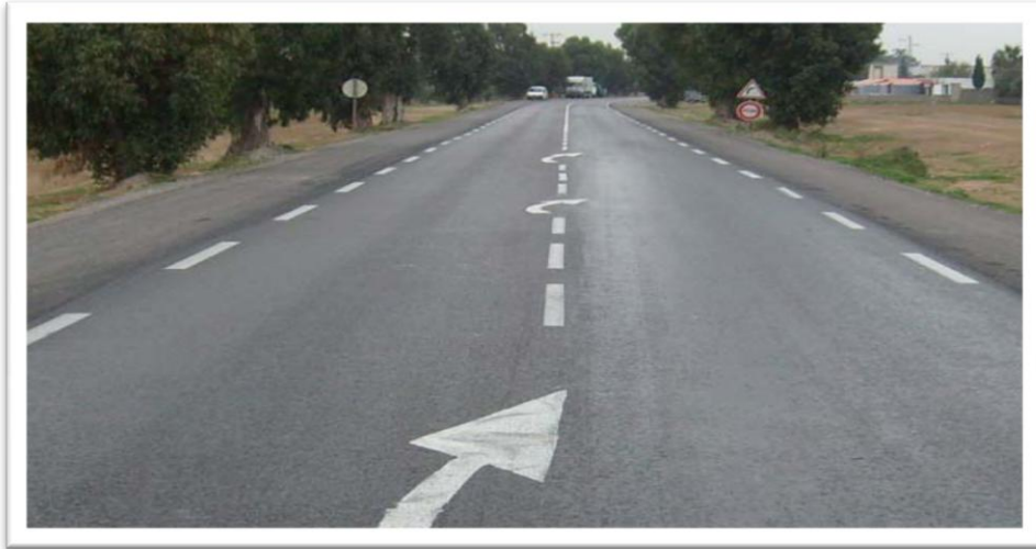
Fig IV .7: Signalisation horizontale de virage.
