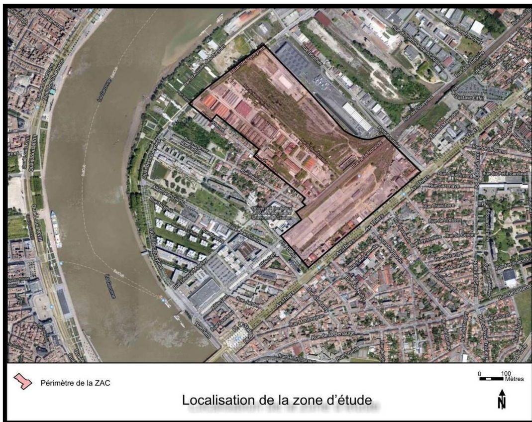
Figure 5. Vue aérienne de la zone d'aménagement concentré
