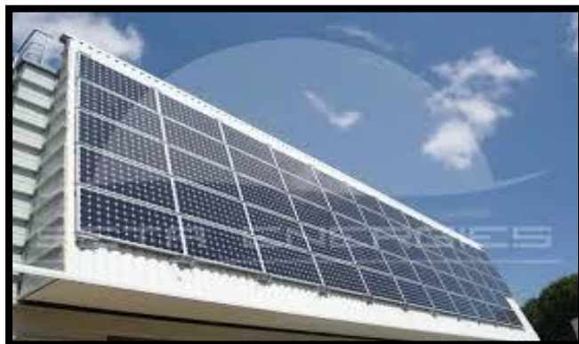
Figure 7. Panneaux photovoltaïques en façades
