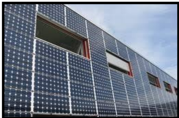
Figure 7. Panneaux photovoltaïques en façades
