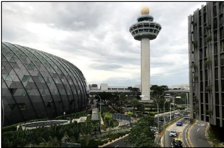
Figure A.7 : Vue de face sue le tour de control
