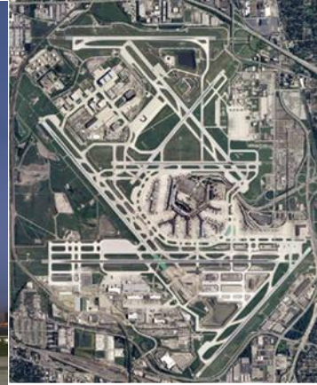
Figure A.21: Vue satellite de l'aéroport
