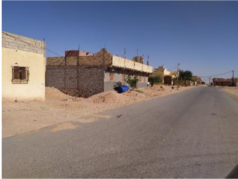
Photo 1 : Vue sur la route existante sur la partie sud de projet
