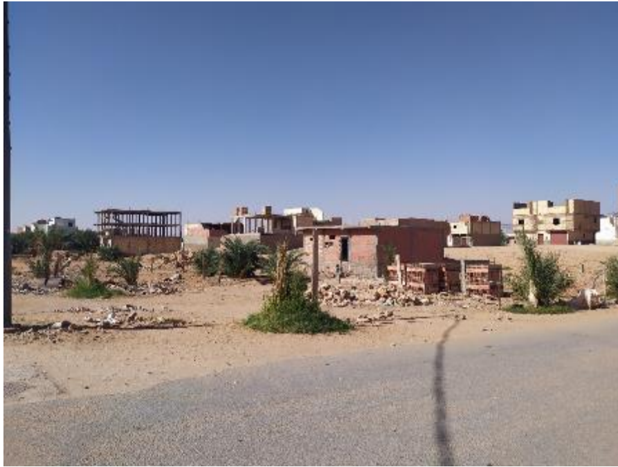
Photo 3 : Vue sur la construction des maisons en cours
