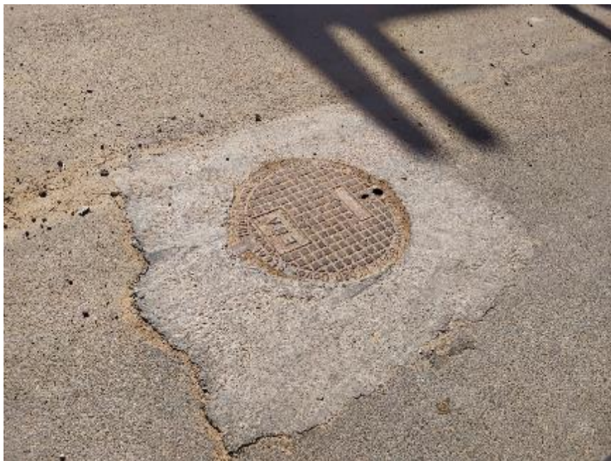
Photo 2 : Vue sur le regard de raccordement d'assainissement
