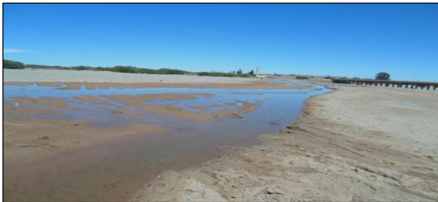
Figure 14 : Vue globale du site d'étude (Barrage de Tadjmout))(Original 2016).
