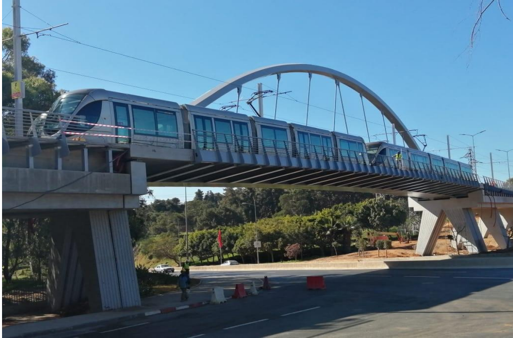
Figure I-5: Exemple Pont mixte arc-poutre
