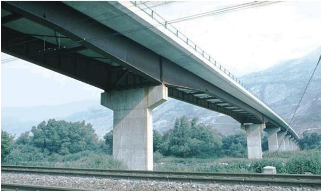
Figure I-7: Exemple Pont mixte à poutres-caissons
