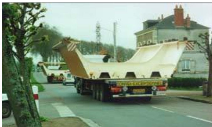
Figure I-12: Cadre de raidissage d'un caisson
