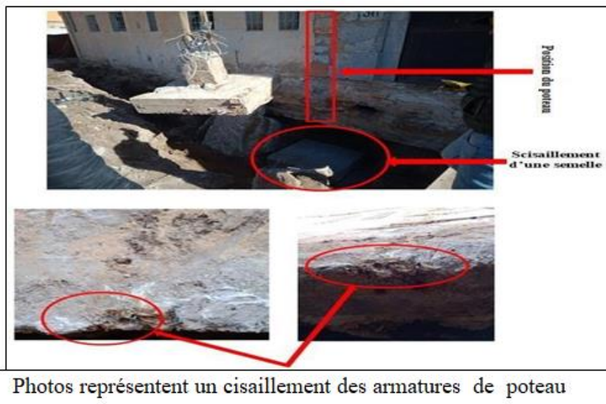
Figure IV-8 : cisaillement
