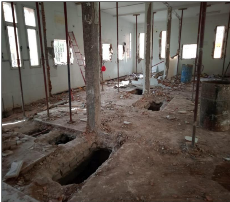
Figure IV-12: sondage effectuée
