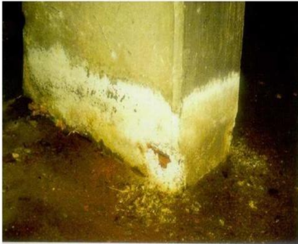
Figure I-11: sulfate externe d'un poteau [6]
