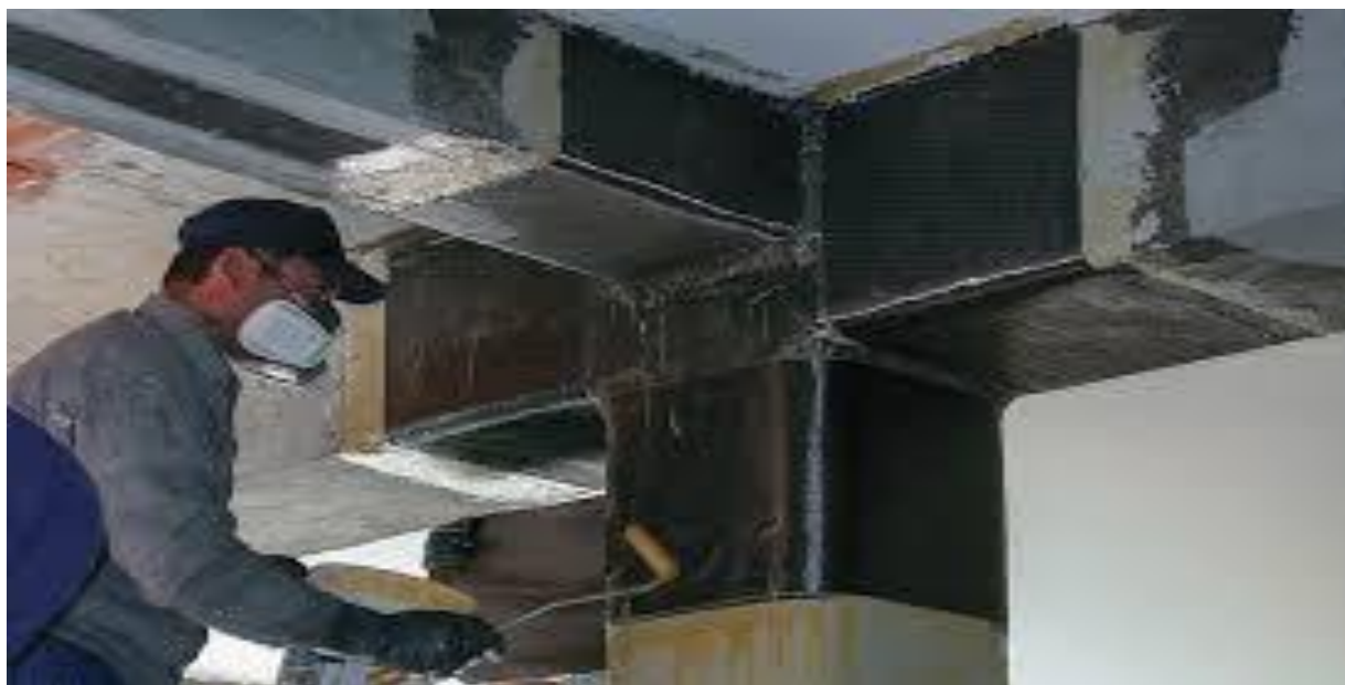
Figure III-14 : renforcement un structure avec un matériau composite
