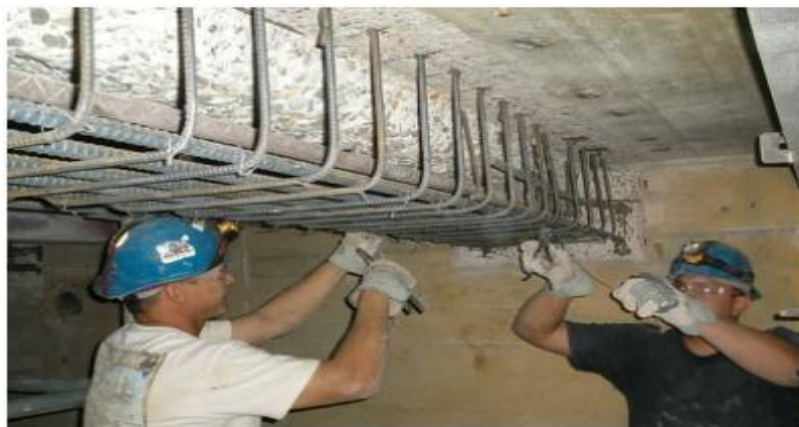
Figure I-2 : renforcement d'une poutre [17]
