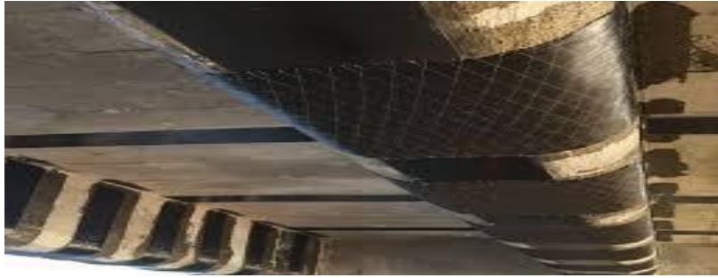
Figure III-5 : renforcement avec tissu de carbone
