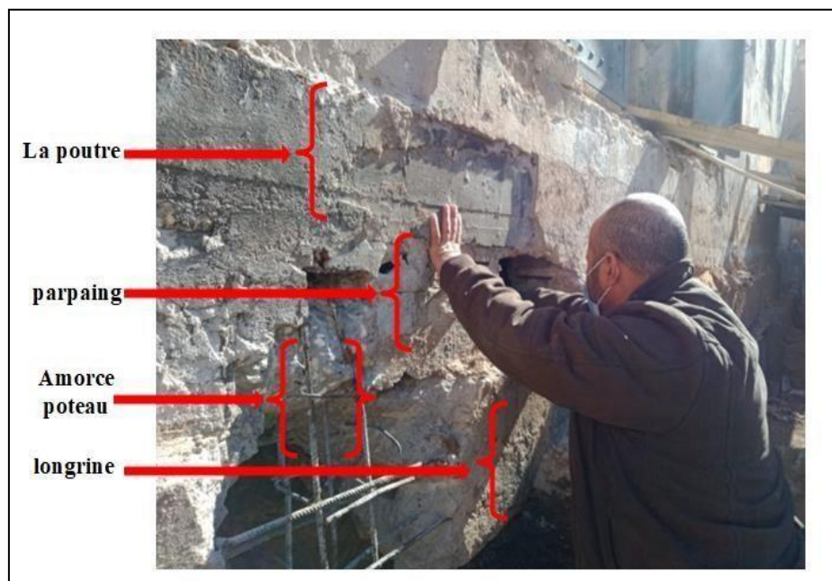
Figure IV-13: constitutions des éléments constructifs
