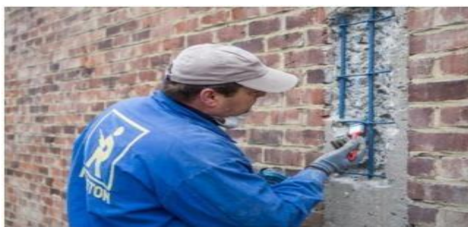
Figure I-1: réparation d'un poteau [17]
