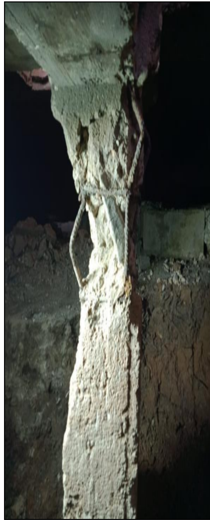
La forme des amorces Poteaux qui Montre Un Tassement de le la structure
