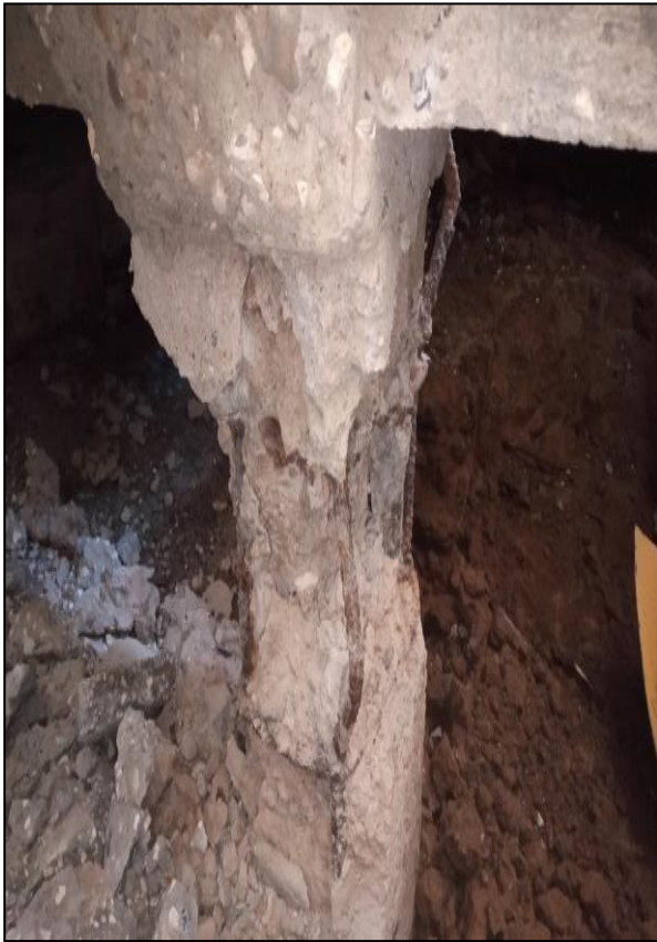
La forme des amorces Poteaux qui Montre Un Tassement de le la structure
