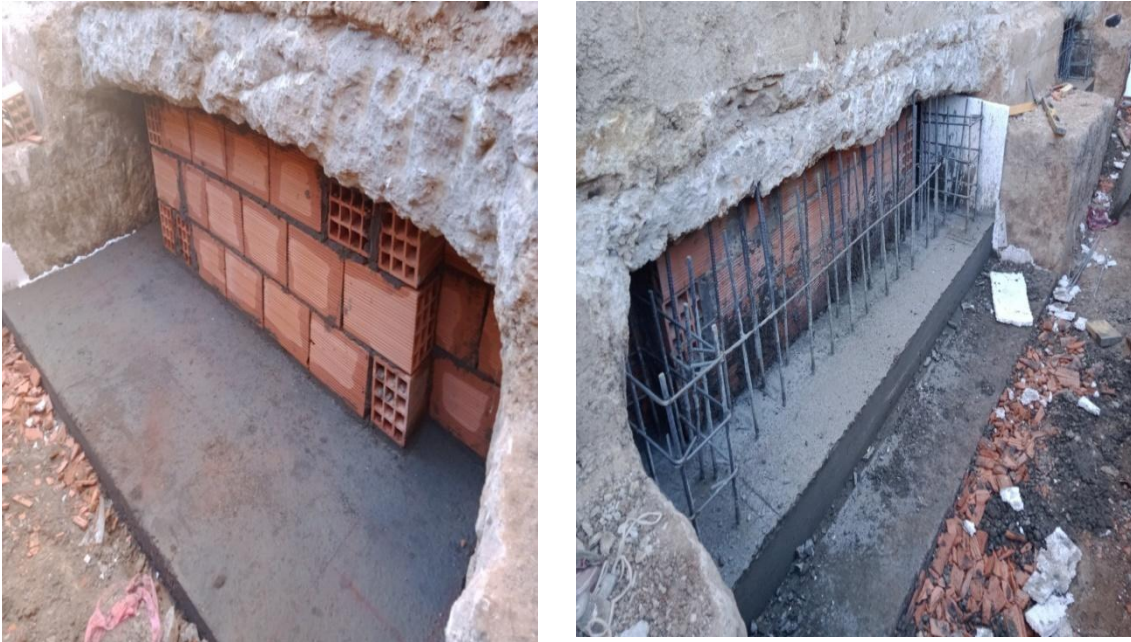
Figure IV-17 : construire semelle filante
