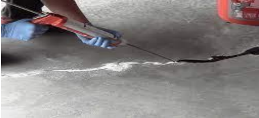
Figure III-13 : injection d'une fissure
