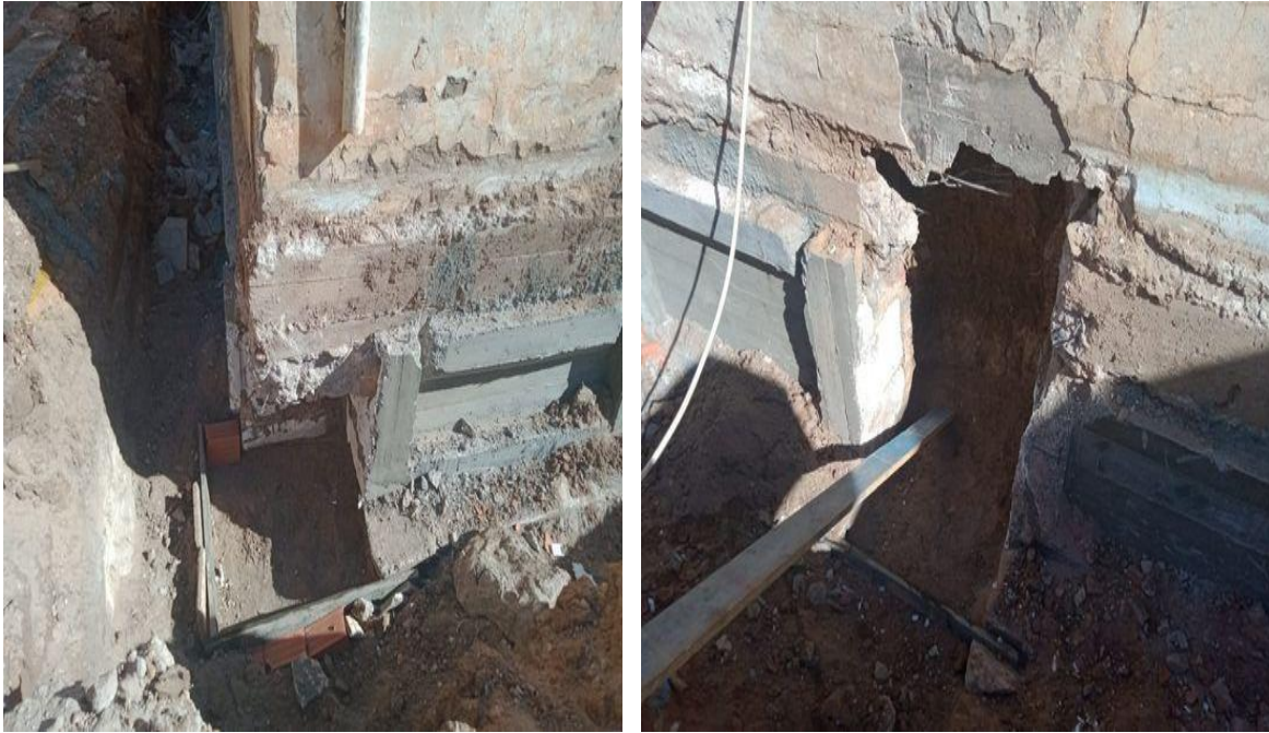
Figure IV-19 : nettoyage l'espace des semelles dégradées
