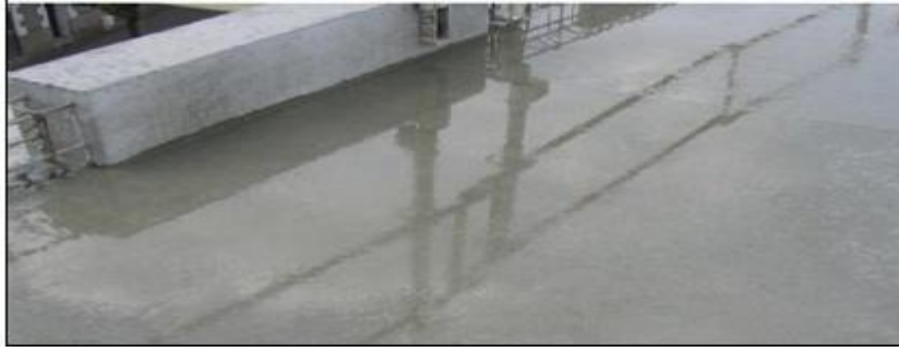
Figure I-15 : ressuage de béton
