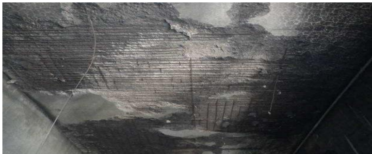
Figure I-16 : l'incendie d'un béton
