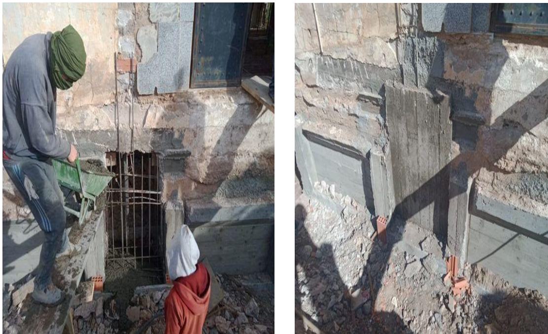
Figure IV-20 : exécution des semelles
