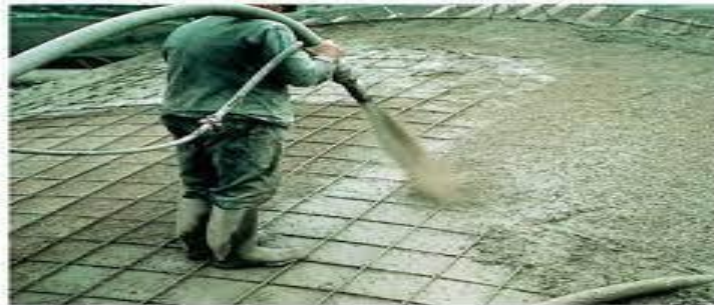
Figure III-2 : béton projeté
