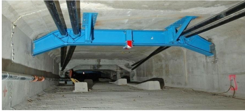
Figure III-8 : la méthode précontrainte additionnelle
