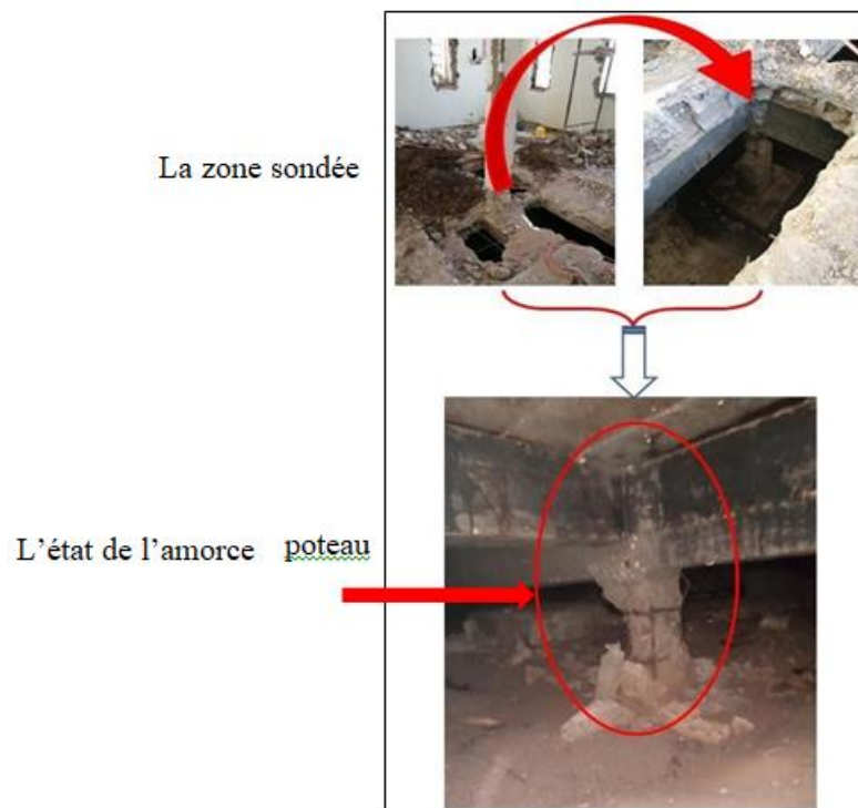
Figure IV-6 : la zone sondage et l'état de l'amorce poteau.
