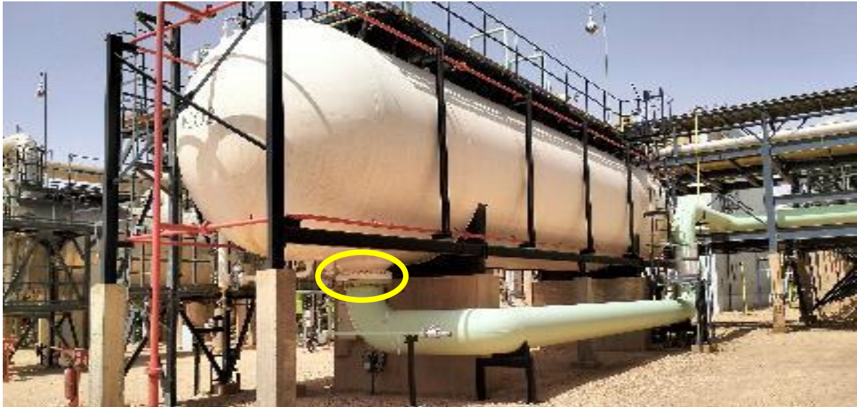
Figure 18 : Ballon accumulateur de propane V302
