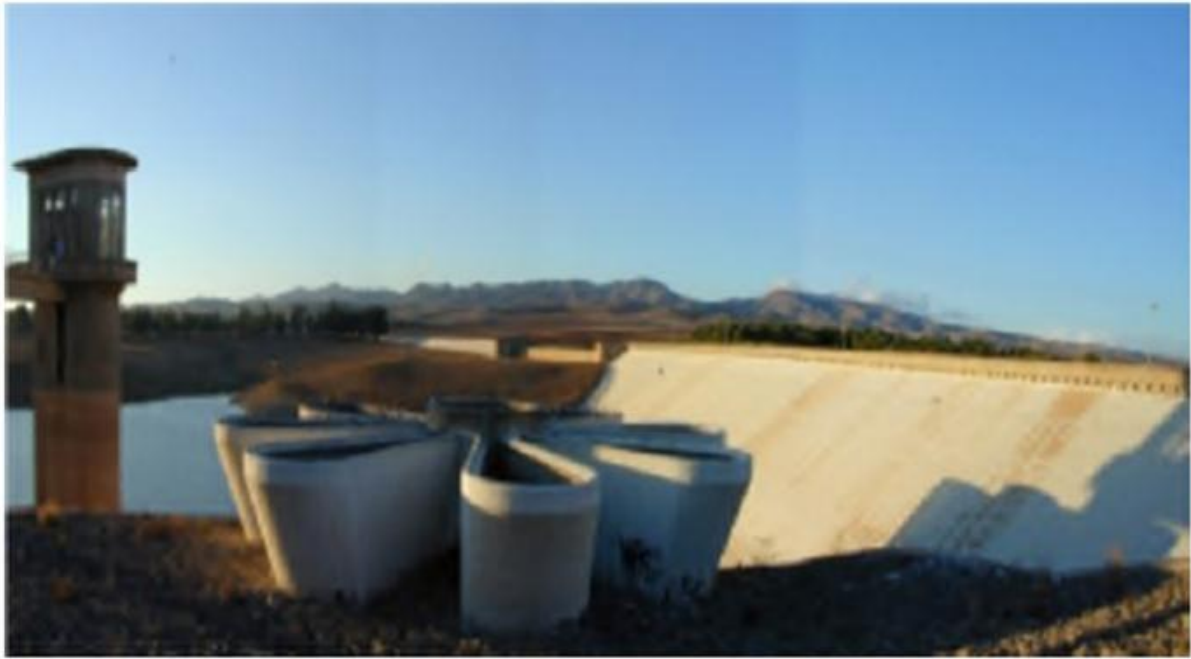
Figure I.11 : Evacuateur en puits marguerite.
