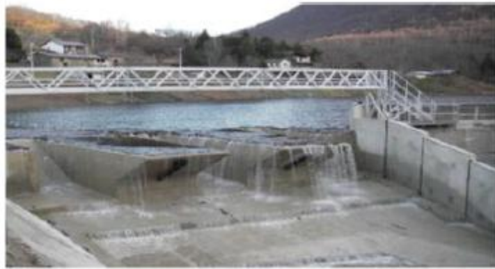
Figure (I-21) : Piano Key Weir sur barrage Goulours (EDF – France).
