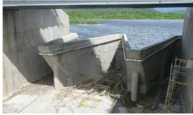
Figure I.19 : Déversoir en labyrinthe du barrage de Song Mong (Viêtnam).
