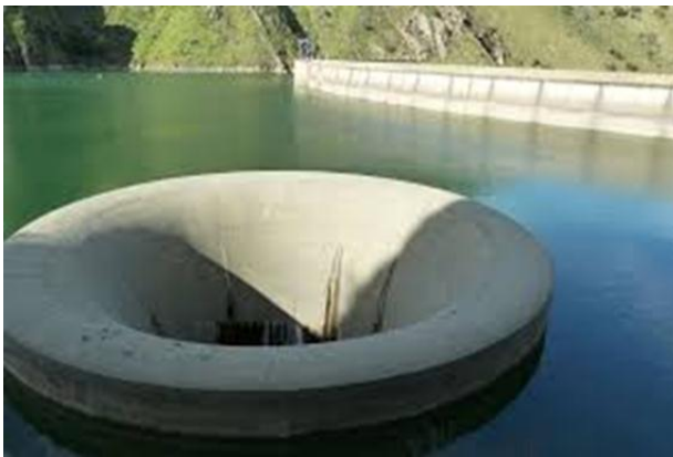
Figure I.7 : Évacuateur de crues en charge.
