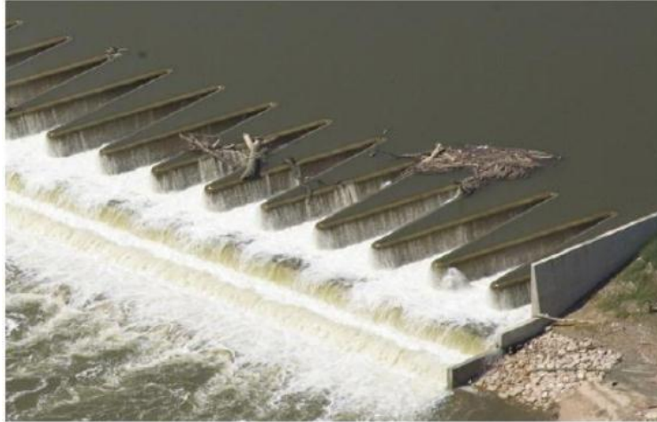
Figure I.18 : Déversoir non rectiligne (barrage Texas, USA).
