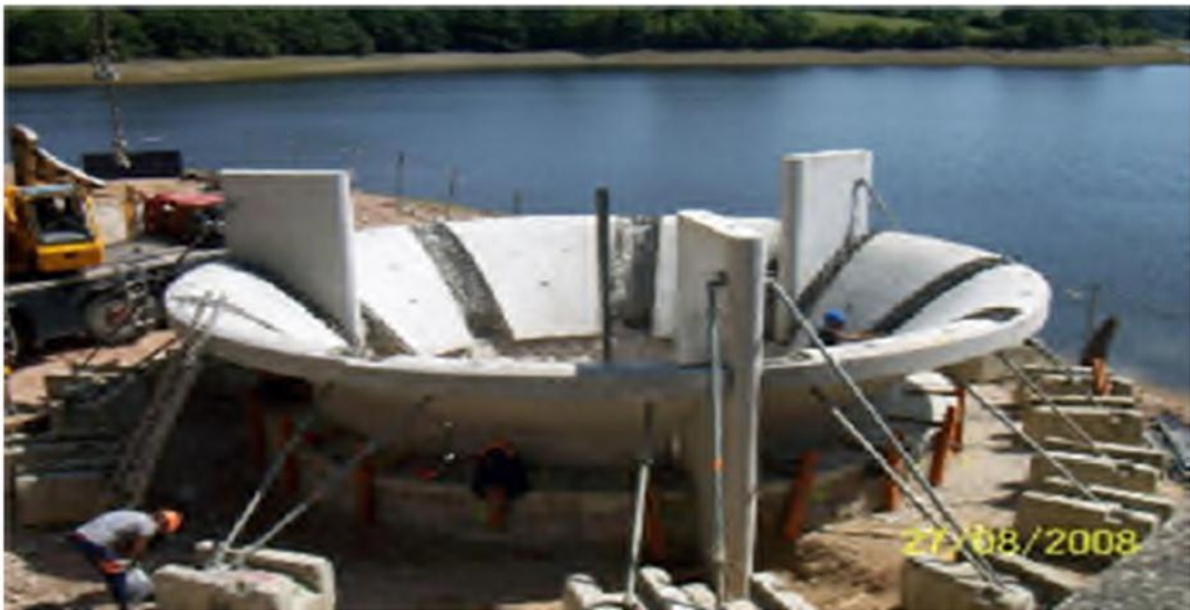
Figure I.10 : Évacuateur en puits circulaire.
