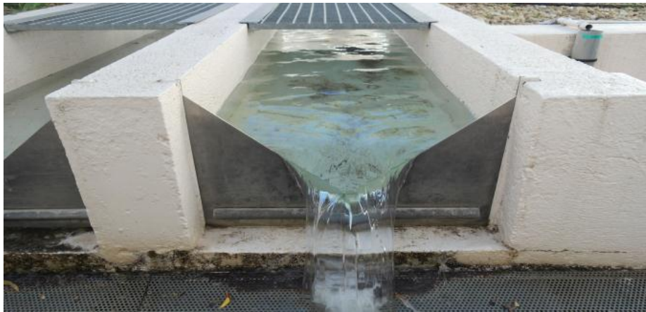
Figure I.12 : Déversoir triangulaire à paroi mince.
