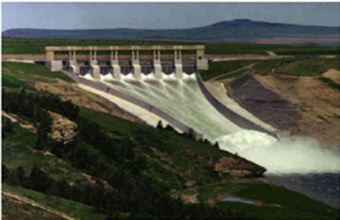
Figure I.4 : Évacuateur de crues de surface.
