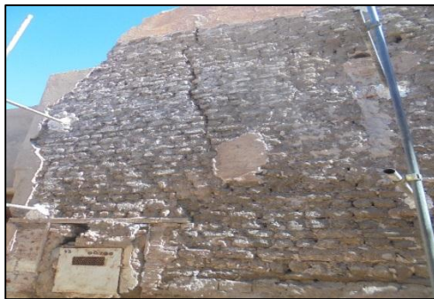
Figure 18,19. II : réparation des façades par traitement des pathologies apparente prise par les étudiantes
