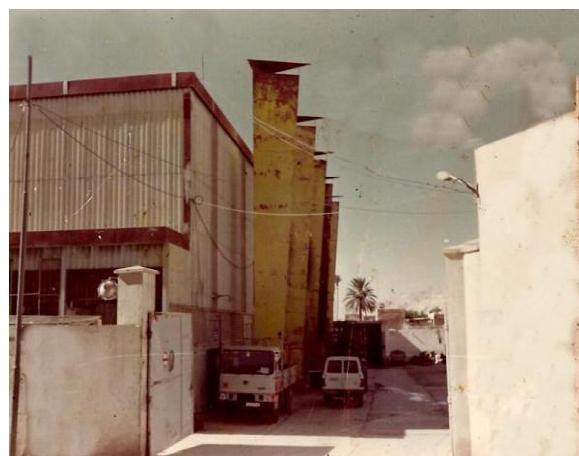
Figure 54.III : Central électrique de Laghouat [28]
