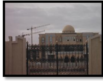
Figure IV .17 : le nouveau siège de wilaya Source : auteur
