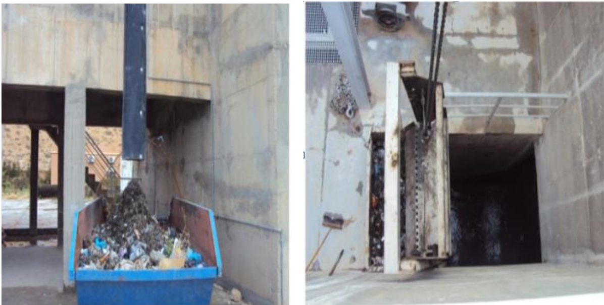
Figure 2: le dégrillage STEP de Laghouat (photo original ,2018).
