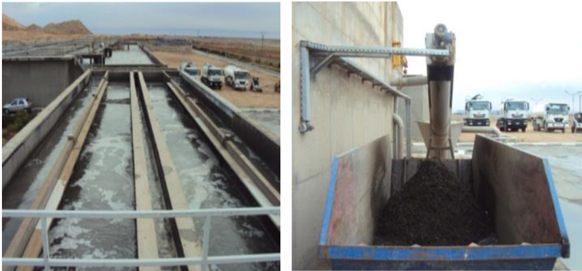
Figure 3: le dessablage STEP de Laghouat (Photo originale, 2018)
