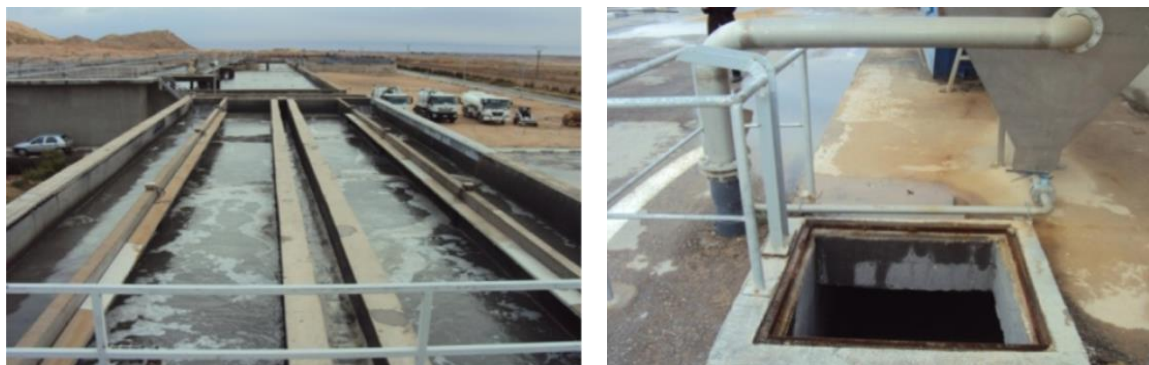
Figure 4: le déshuilage STEP de Laghouat (Photo originale, 2018)
