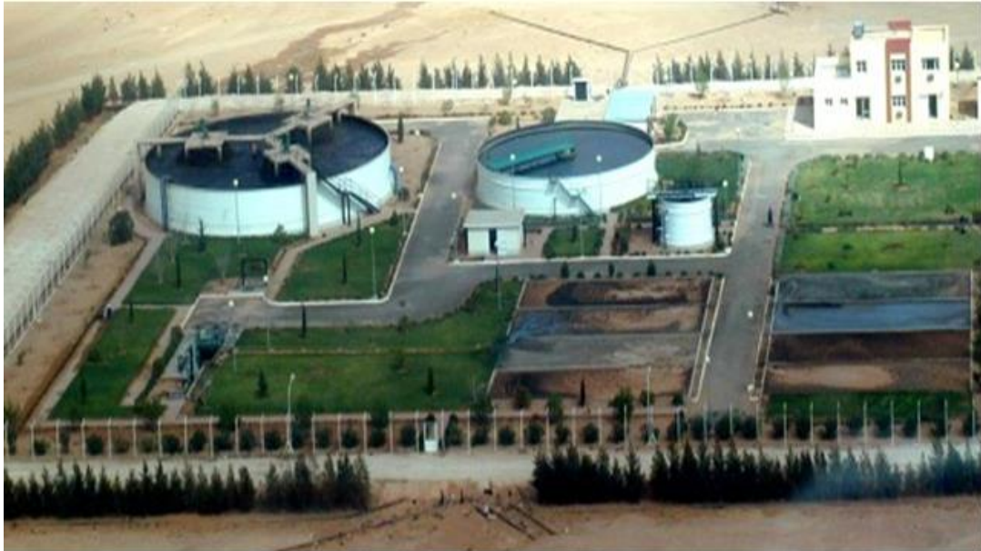
Figure 10: station d'épuration de HASSI R'MAL (STEP de HASSI R'MAL, 2016).
