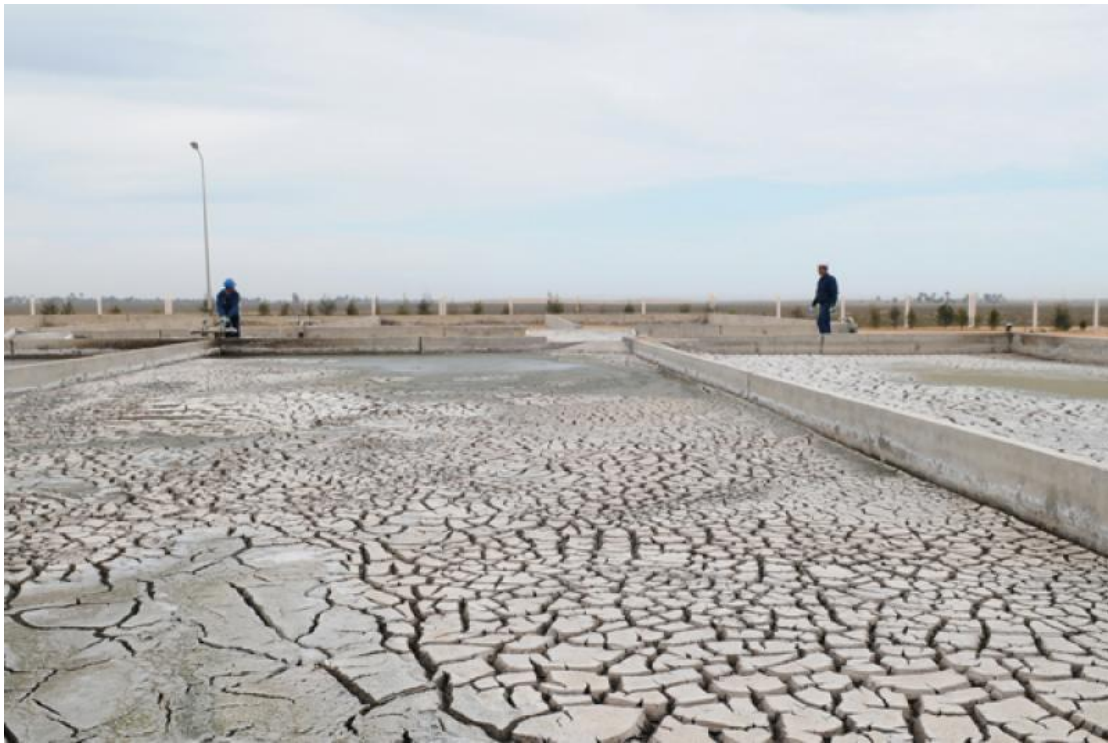
Figure 7: Un lit de séchage STEP de Laghouat ( Photo originale, 2018 ).
