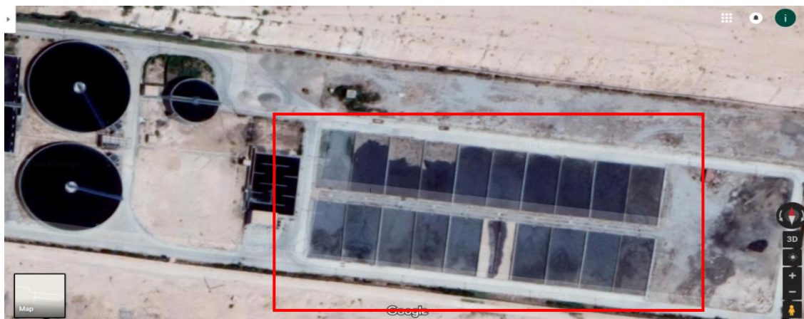
Figure 10 : Image satellite des lits de séchage – STEP Laghouat (Google Earth, 2018).
