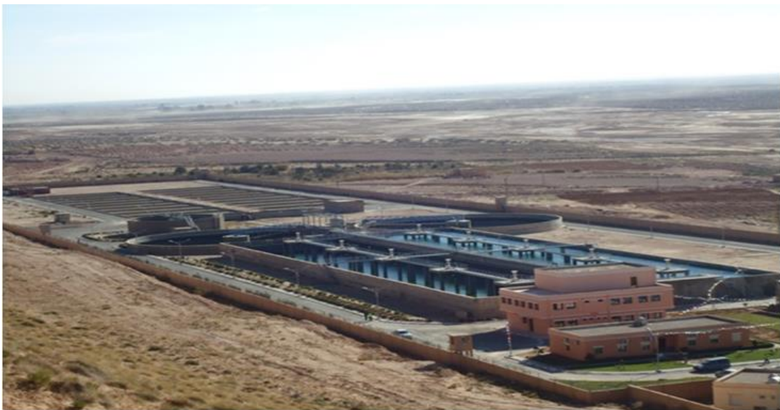
Figure 8: Vue d'ensemble de la station d'épuration de Laghouat ( STEP-Laghouat, 2015 ).
