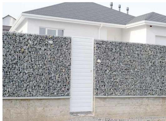
Figure 16 : Mur de clôture. Source : www.maisonentravaux.fr
