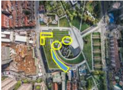
Figure 43 : toiture végétalisée Source : Auteur
