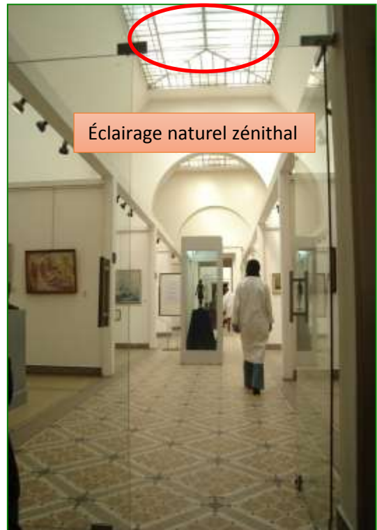
Figure 130 : Éclairage naturel Zénithal a travers des verriers Source : Auteur
