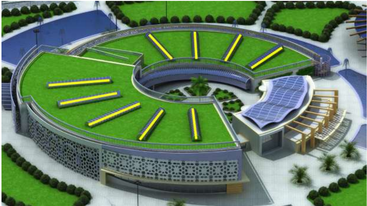
Figure 249 : L'utilisation des sheds Source : Auteur
