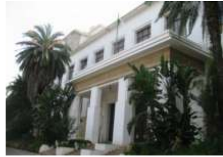
Figure 102 : entrée principale Source : http://www.algerie-monde.com
