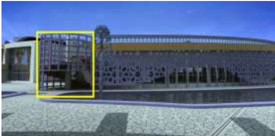
Figure 243 : l'utilisation des escalier extérieure pour accéder vers la toiture Source : Auteur
