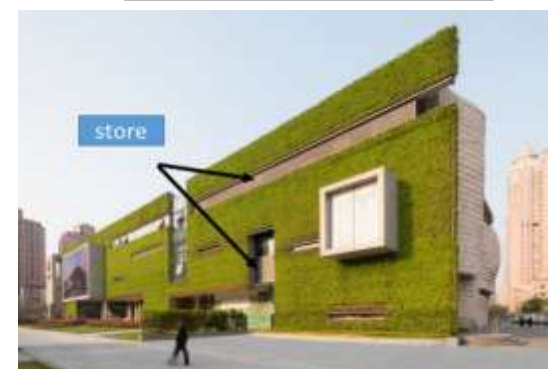
Figure 40 : façade est Source : Auteur
