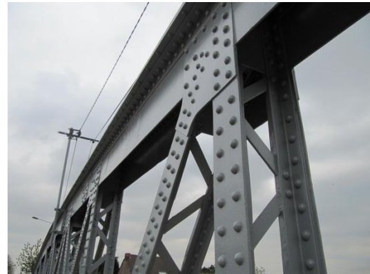
Fig V.21 : assemblage par rivets / source : : cours 3eme année : Mr boukhalkhal A
