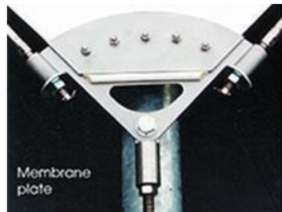
Fig V.26 : le montage de la membrane de structure textile / source : : cours 3eme année : Mr boukhalkhal A
