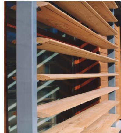
FigI.19: Brises-soleils horizontaux amovibles/ Source : livre de la conception bioclimatique
