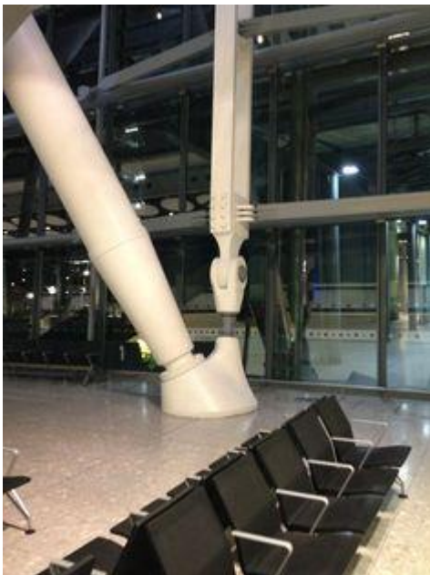
Fig V.36 : fixation de l'ossature au sol et plancher / source : HDR_maurin.pdf
