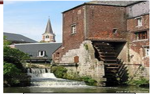
FigI.34: énergie hydraulique /Source : cour Mme boucherb.z (M1envirenement)
