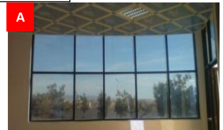
FigureVI (68) :Stratégie de capter /source : Le confort visuel et l'ambiance lumineuse dans l'espace architectural.pdf
