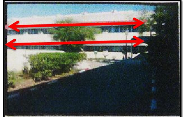
FigII.60 :vue sur la facade du centre de toxicologie / source : auteur
