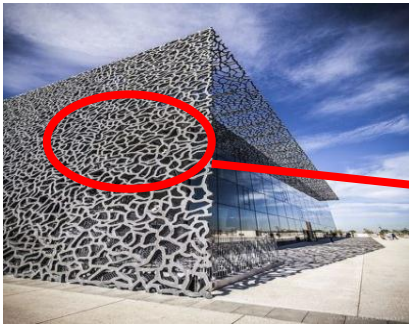
Protection solaire horizontal en grille
