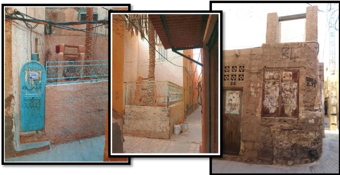
Figure N° 70 : Les Puits dans le ksar. Source : Prise par auteur.
