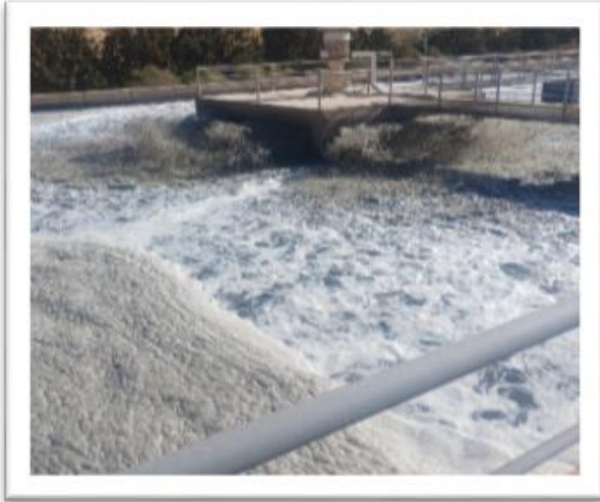
Figure 6. Bassins d'activation de boues
