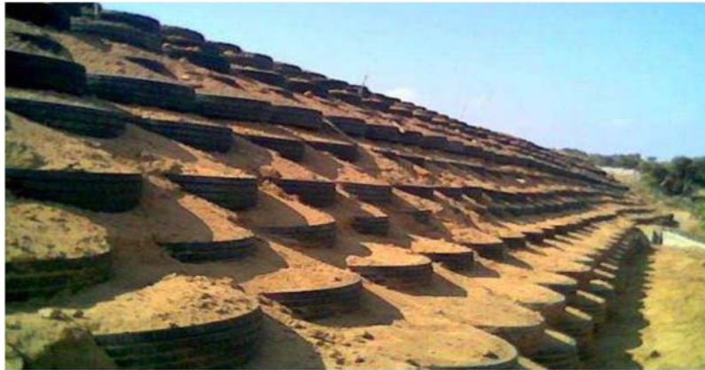
Figure I.4. Chantier expérimentale Pneu sol à Bou-Smail [29].
