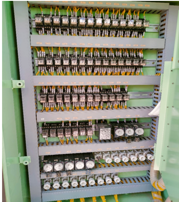
FIGURE 1.8 – Armoire de logique câblée
